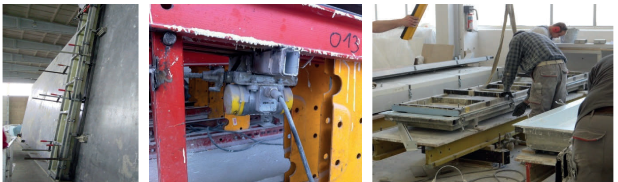
Abb. 9.28: Senkrechte Produktion (li.), Verdichtung mit Außenrüttlern (mi.), Vorbereitung Entschalung (re.)
