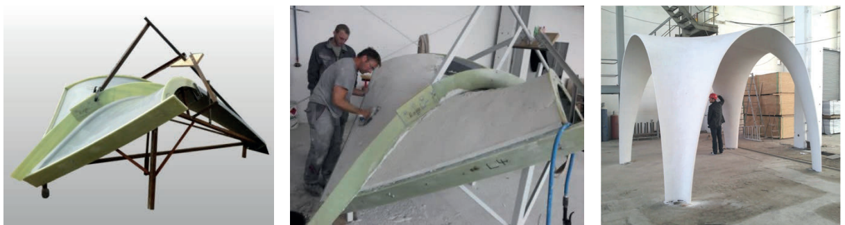
Abb. 5.33: GFK-Schalung (li.), Betonage eines Einzelementes in GFK-Schalung (mi.), Probeaufbau (re.)
