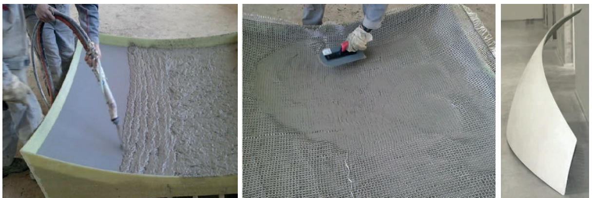
Abb. 6.11: Fertigungsschritte der Elemente des BetoTexG-Hybridpavillons CoFigloo
