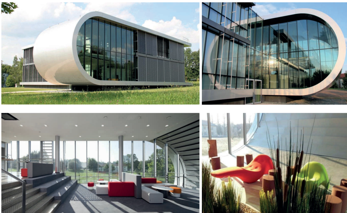
Abb. 9.18: Impressionen MeTeOr-Gebäude (ITS-Schale außen und Innenansichten) [TU Chemnitz]
