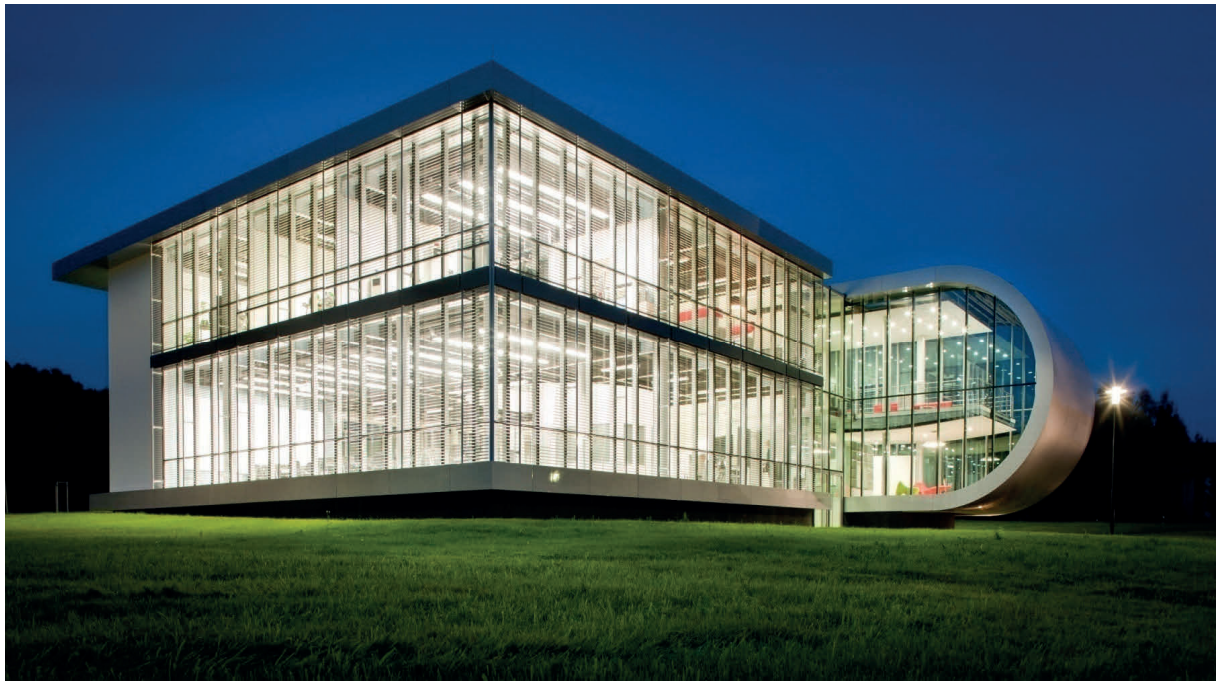
Abb. 4.15: MeTeOr-Gebäude der TU Chemnitz mit ITS-Schale
