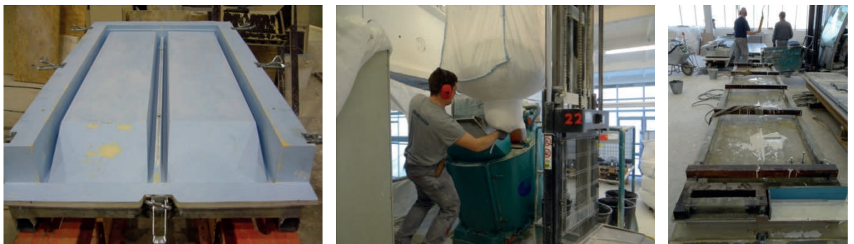
Abb. 9.27: Auftrag Trennmittel in Schalung (li.), Eingabe Komponenten in Mischer (mi.), Gießformgebung (re.)
