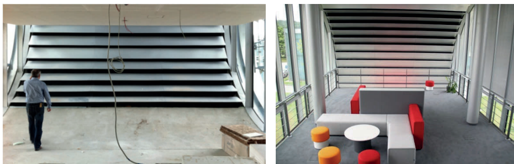
Abb. 9.3: ITS-Fassade mit integrierten Akustiklamellen
