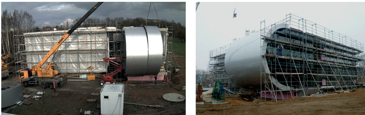
Abb. 9.17: Montage Mittelmodule (li.), Fertigstellung Montageprozess ITS-Fassade (re.)
