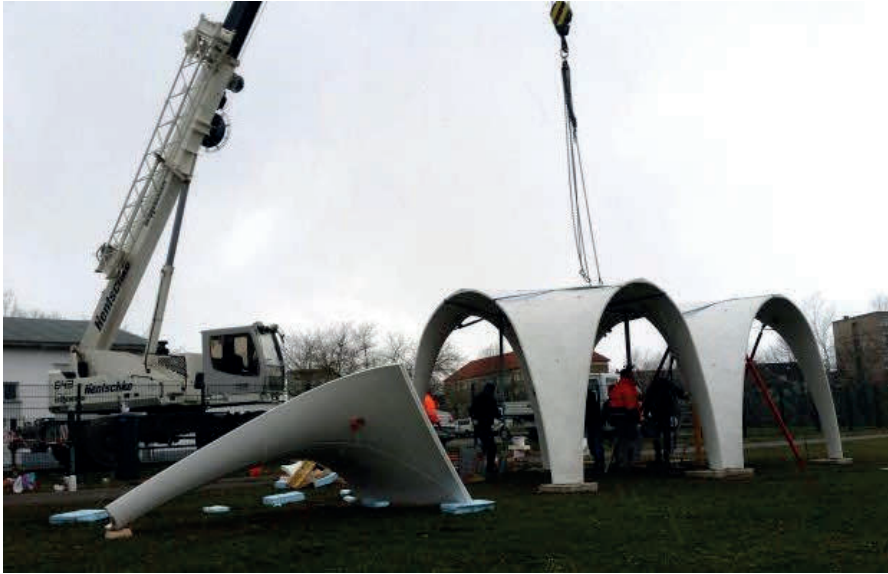
Abb. 9.43: Errichtung der Textilbeton-Pavillons „TexLeS“ auf dem Campusgelände der TU Chemnitz
