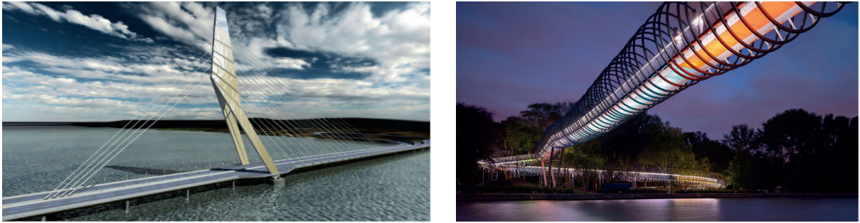
Abb. 3.6: Yamuna-Brücke in Waziraba, Indien (li.), Spannbandbrücke in Oberhausen (re.) (Entwurf: Schlaich, Bergermann & Partner)
