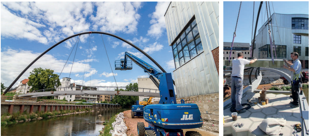
Abb. 4.45: Montage Überbau [Baby Smile Fotografie GmbH&Co.KG] (li.), Einbau der GFK-Wabenmodule (re.)
