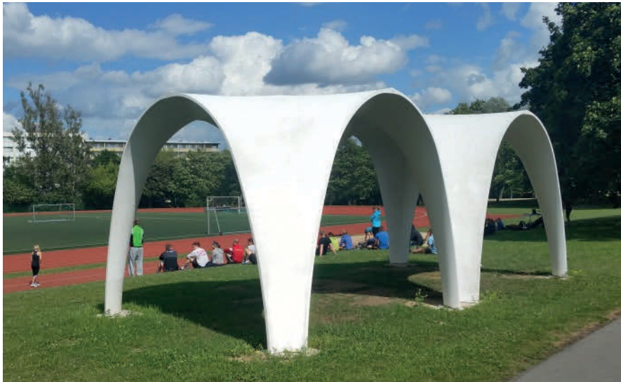
Abb. 9.44: Textilbeton-Pavillons „TexLeS“ auf dem Campusgelände der TU Chemnitz
