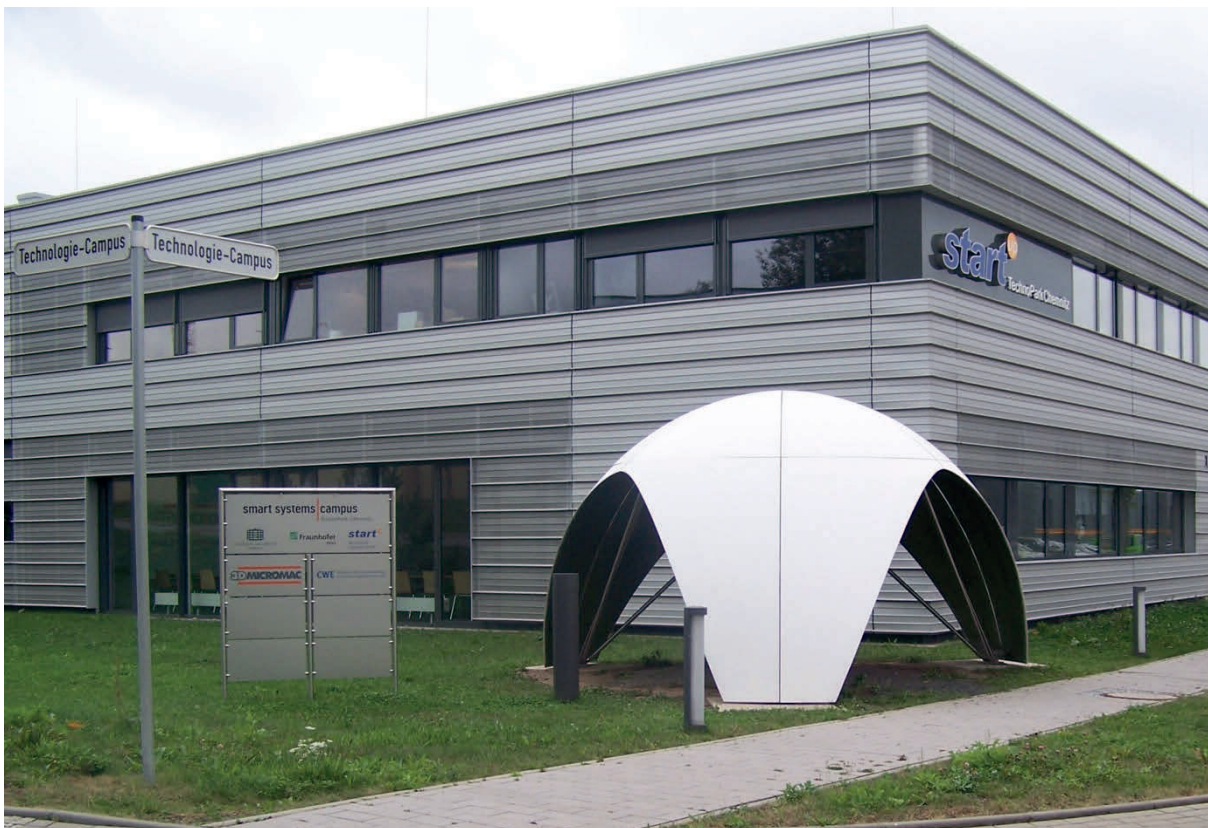
Abb. 9.49: Fertiggestellter Forschungspavillon CoFigloo
