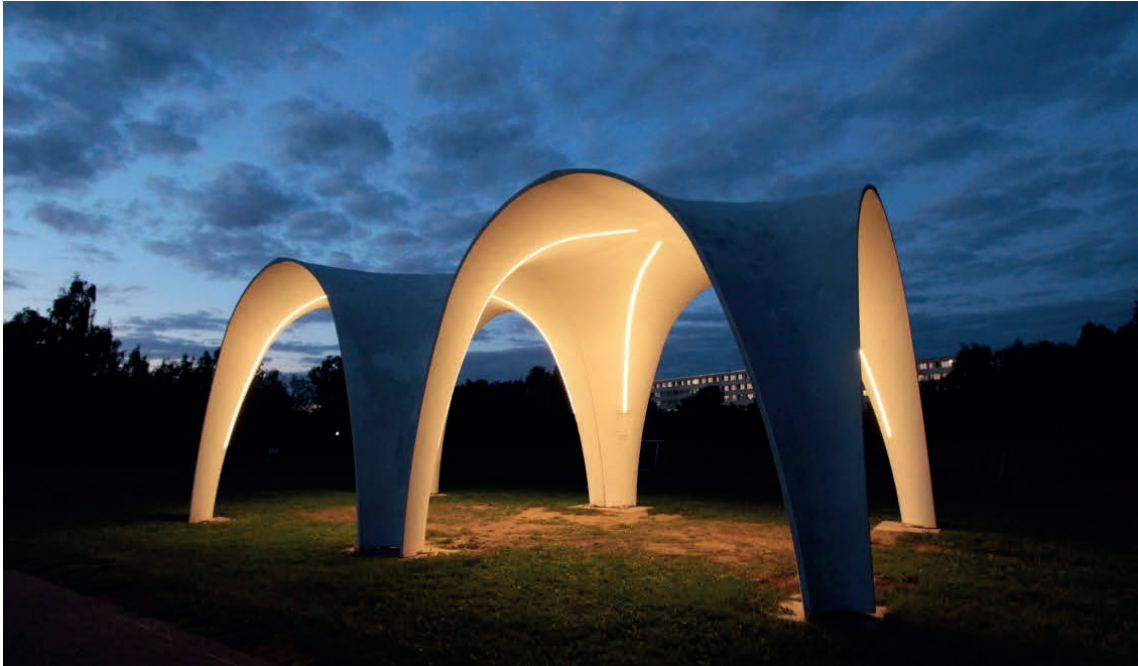
Abb. 5.37: Textilbeton-Pavillons auf dem Campusgelände der TU Chemnitz mit integrierter Beleuchtung
