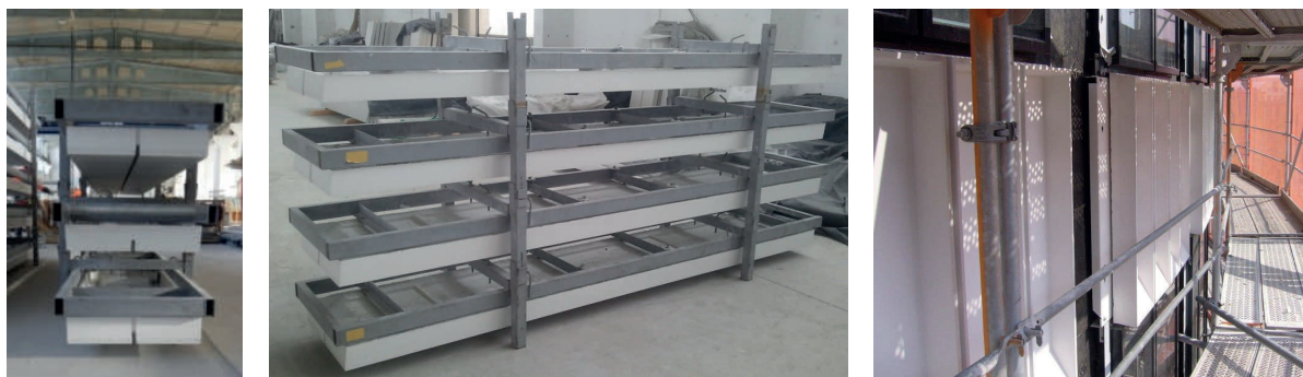
Abb. 9.30: Gestell für Transport der Elemente auf die Baustelle (re., mi.), Montage auf der Baustelle (re.)
