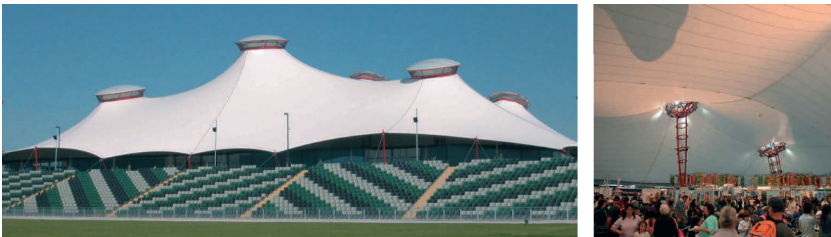
Abb. 3.10: Pavillon-Melbourne Showgrounds, Australien (Mehler Technologies GmbH)
