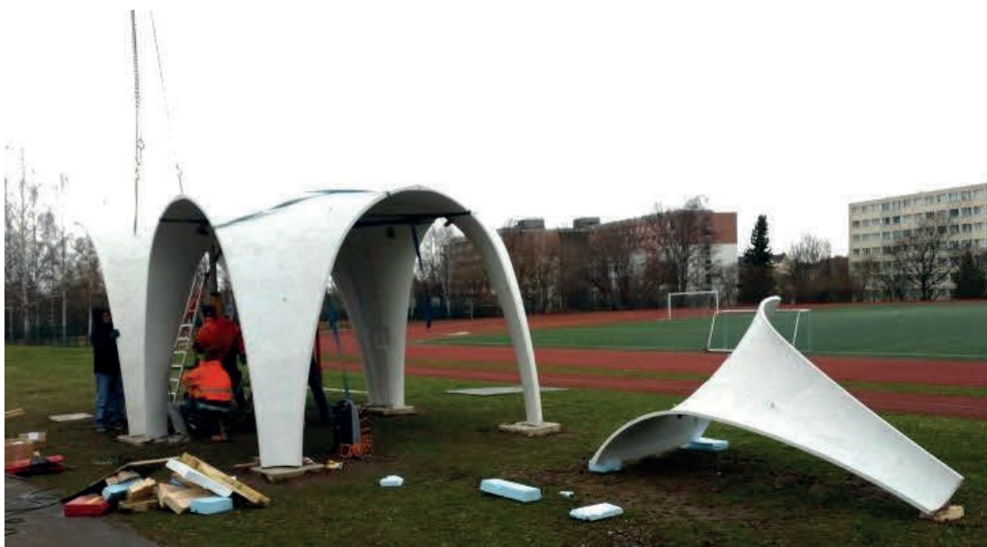
Abb. 9.42: Errichtung der Textilbeton-Pavillons „TexLeS“ auf dem Campusgelände der TU Chemnitz
