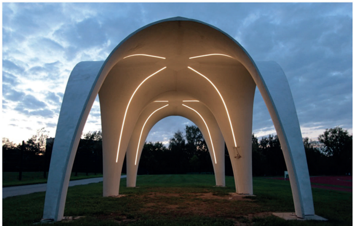
Abb. 5.38: Textilbeton-Pavillons auf dem Campusgelände der TU Chemnitz mit integrierter Beleuchtung
