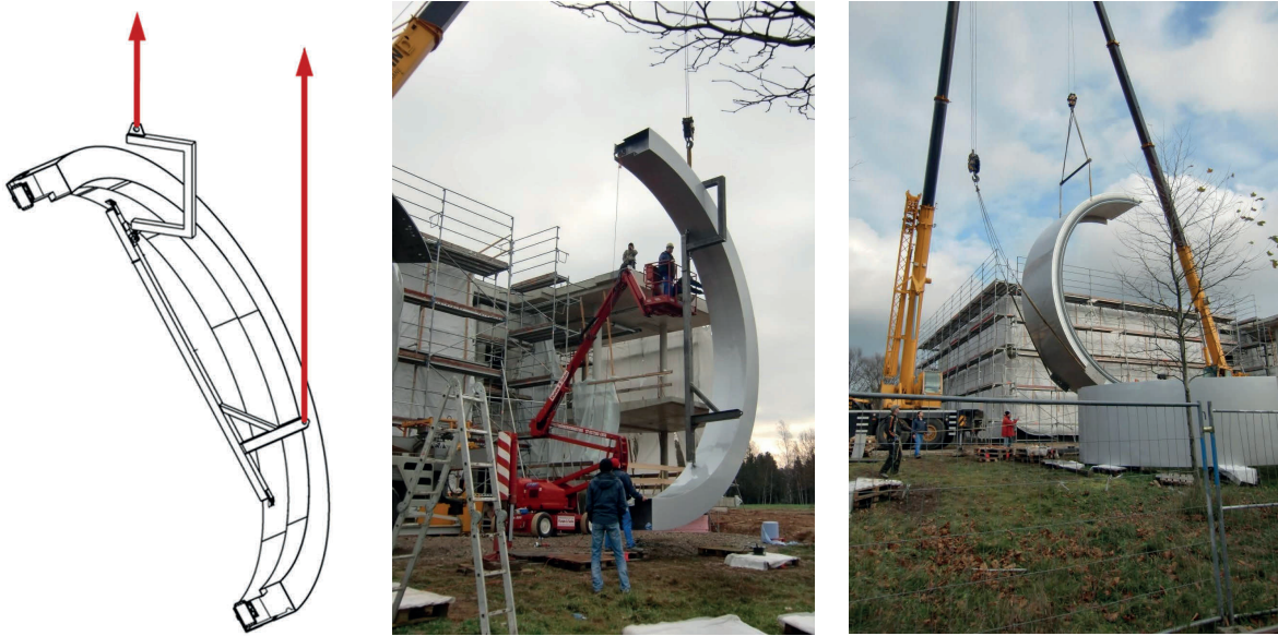
Abb. 9.16: Montage Module; Manipulationsvorrichtung (li.), Randmodul (mi.), Mittelmodul (re.)
