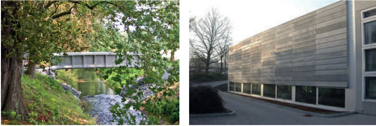
Abb. 3.17: Weltweit erste Brücke aus Textilbeton im Gelände der Landesgartenschau Oschatz (li., [TU Dresden]); Erweiterung der Versuchshalle C, IMB RWTH Aachen (re., [RWTH Aachen])
