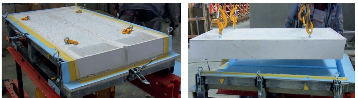
Abb. 9.29: Entschalung: Demontage Formrückwand (li.), Entformung Betonelement (re.)
