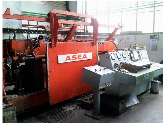
Abb. 3.2: Die hydrostatische Strangpressanlage der Fa. CEP in Freiberg
