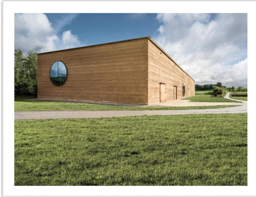
Figura 4. Construcción de tierra
