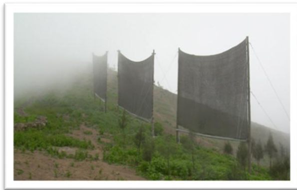
Figura 25. Sistema de captación de niebla
