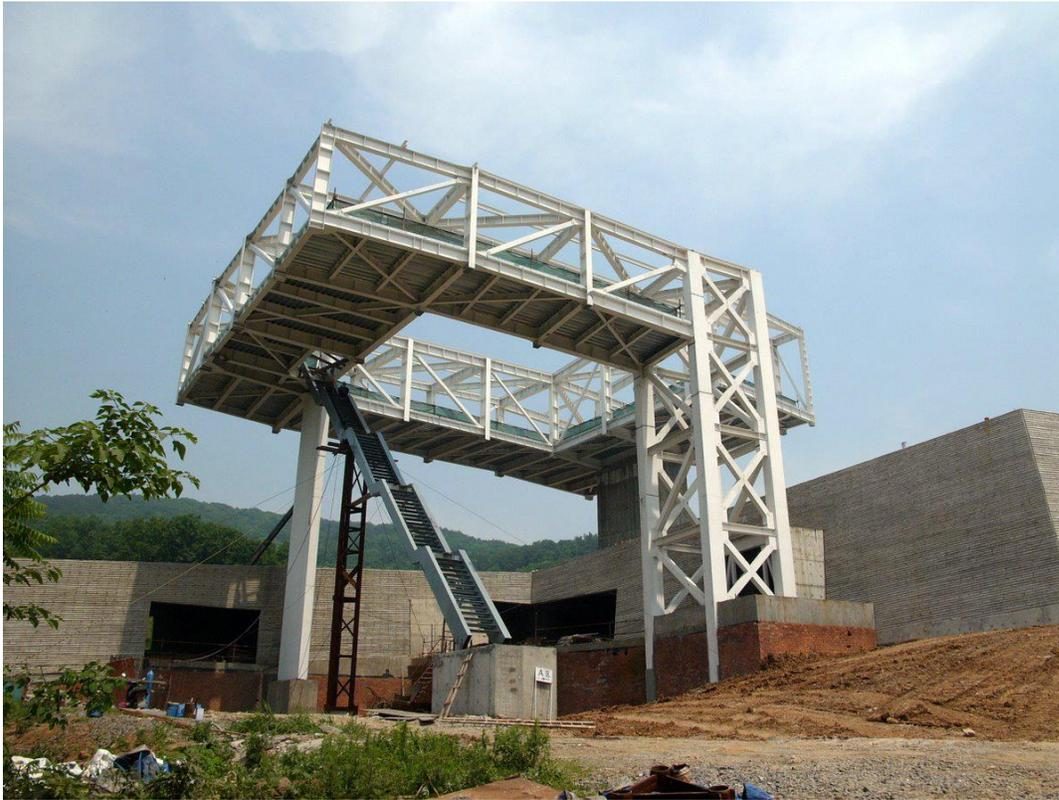
**Figura 4:** Estructura metálica (viga vierendel)
