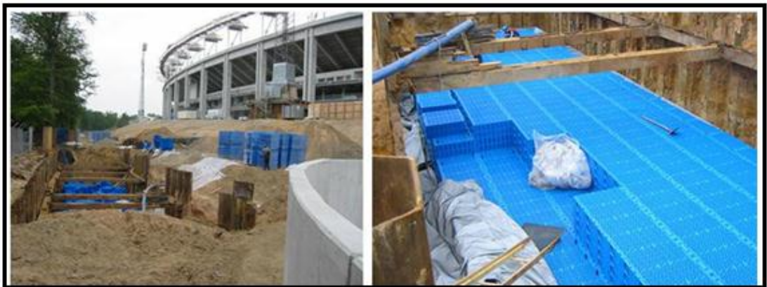
Figura 4. Construcción de estanque de almacenamiento subterráneo con canastillas Aquacell.
