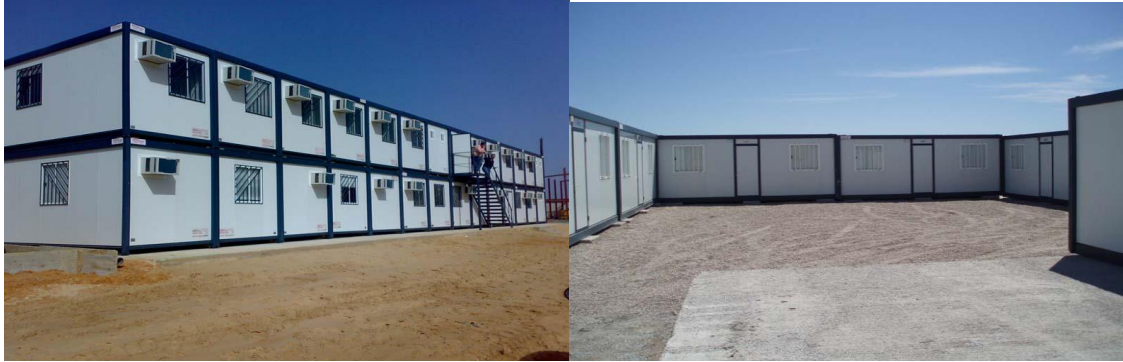
Figura 4 - Campamento de obra
