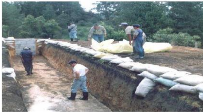
Figura 10. Fosa o zanja.
