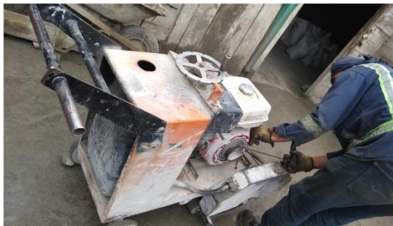
Ilustración 13 Planta Eléctrica en Mal Estado y Dura de Encendido
