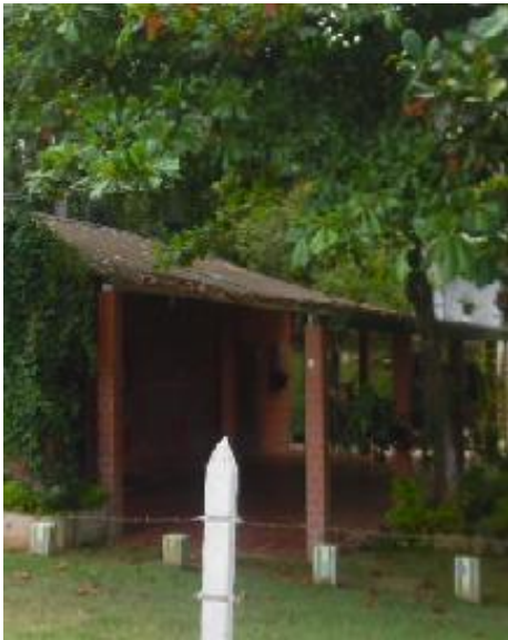
Figura 4. Vivienda en clima templado.
