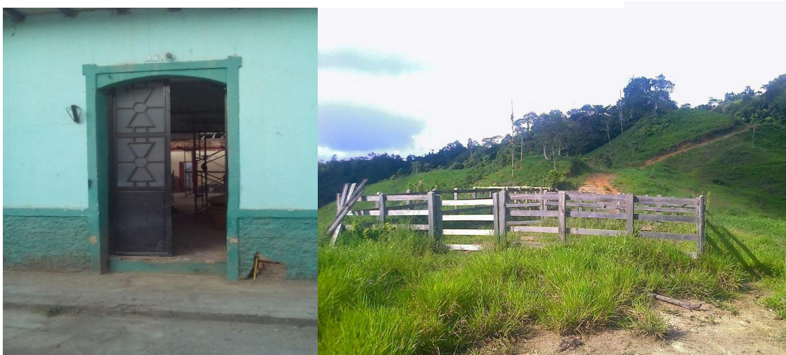
Figura 6. Casas abandonadas por el desplazamiento.
