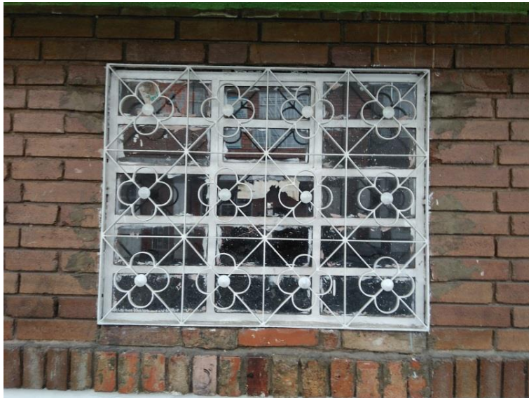
Ilustración 29 Fotografía de detalle en fachada de 1er nivel. Toma propia 2017.
