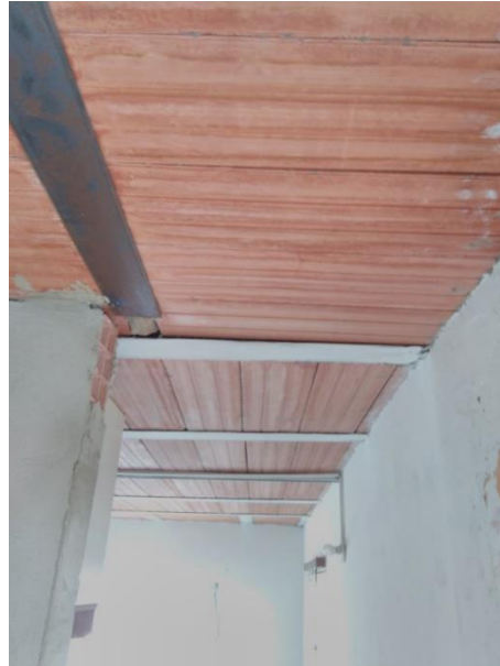
Ilustración 45 Fotografía demostrando la materialidad interna de la vivienda. Placas de entrepiso. Toma propia 2017
