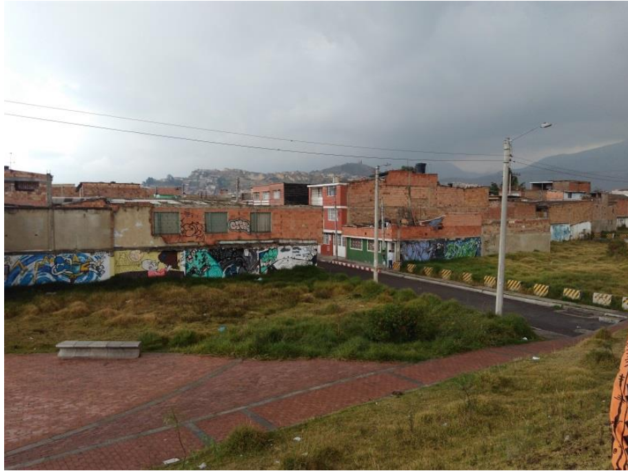
Ilustración 23 Fotografía contexto inmediato de la vivienda. Toma propia 2017.
