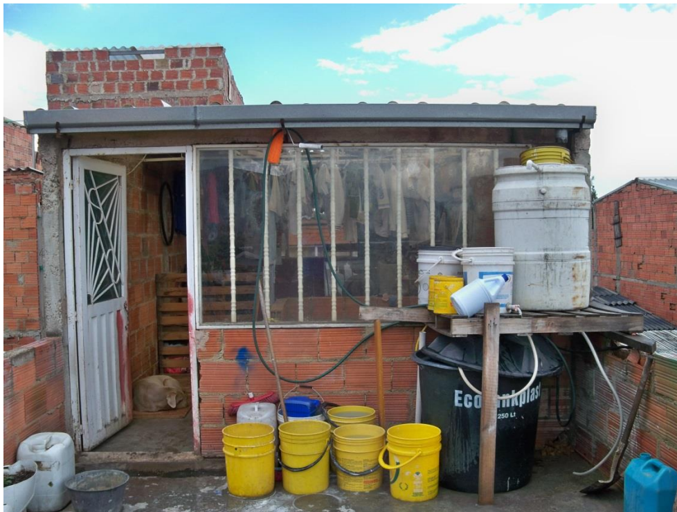
Ilustración 20 Fotografía sistema de uso de aguas lluvias. Toma propia 2017.
