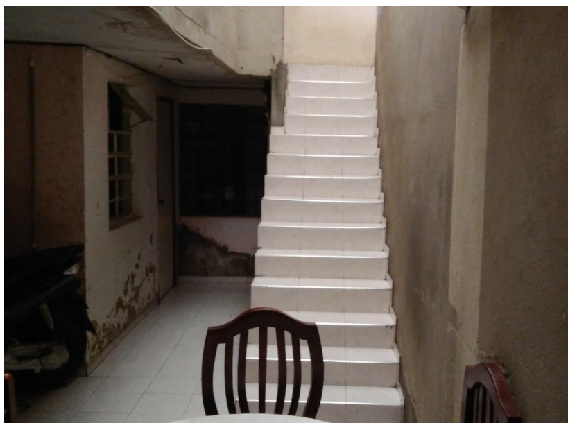
Ilustración 31 Fotografía demostrando la humedad en espacios sin uso en este momento, además elementos de circulación sin remate (escalera). Toma propia 2017.
