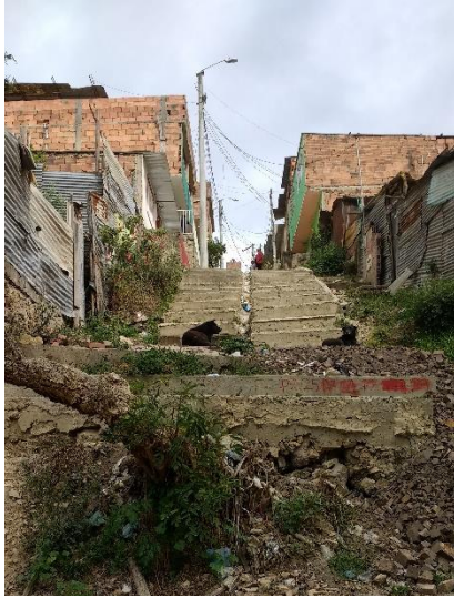
Figura 4: Deterioro de la vía peatonal en el acceso al área de cesión (fuente propia)
