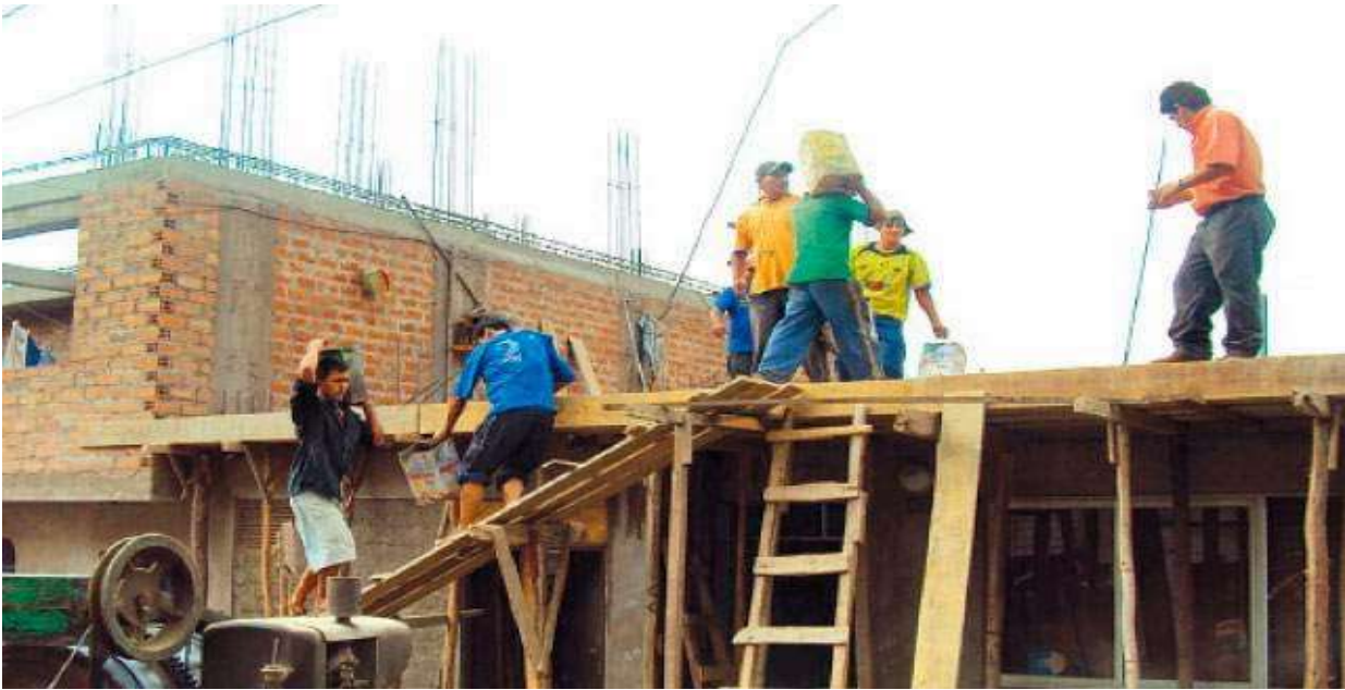
Figura 2. Informalidad en la construcción. Fuente. elmaestrodecasas.blogspot.com (2014)
