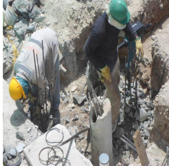
Fuente: El Autor. Figura 12. Descabece de pilotes
