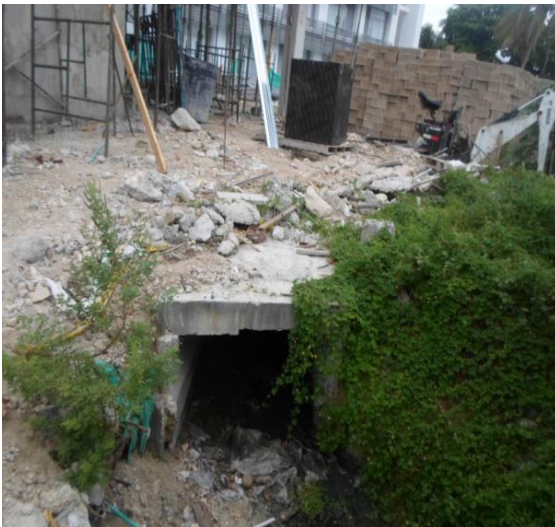
Fuente: El Autor. Figura 13. Desperdicio de Bloque sector 1.
