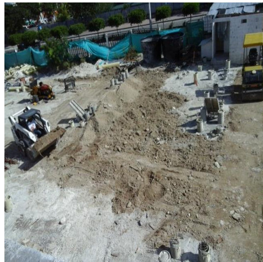
Fuente: El Autor. Figura 6. Material de Excavación terraceo
