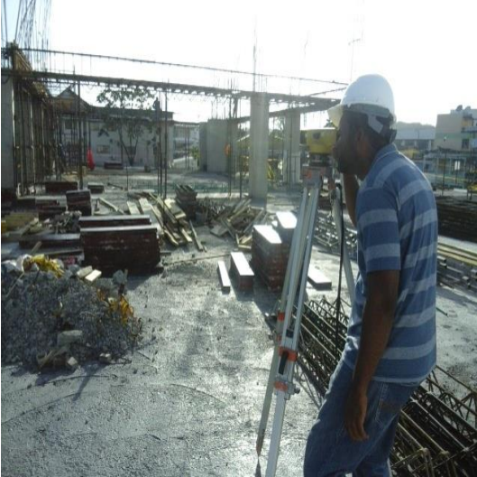
Fuente: El Autor. Figura 11. Desperdicio de concreto
