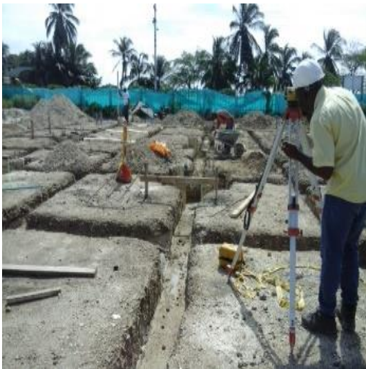
Fuente: El Autor. Figura 5. Material de Excavación vigas cimentadas
