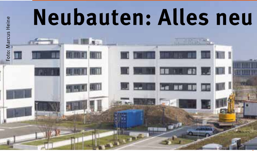
Blick auf das fast fertige Gebäude FH Plus 3 auf dem FH-Campus |
