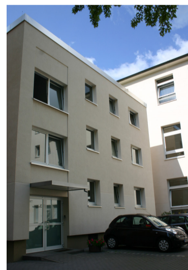
Die Häuser C und D wurden ebenfalls energetisch saniert.
