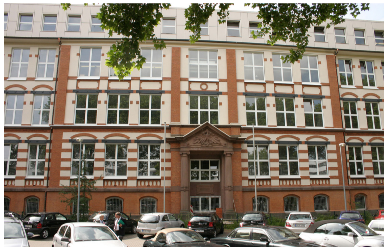
Fassade nachher: Nach der energetischen Sanierung präsentiert sich die Hauptfassade wie zur Wende zum 20. Jahrhundert.
