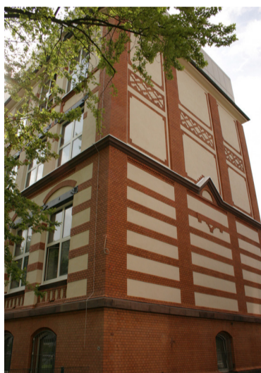
Die schönen Backsteinornamente sind wieder sichtbar.
