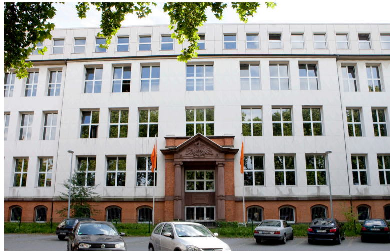
Fassade vorher: Die alte Blechfassade aus den sechziger Jahren besaß keinerlei Dämmfunktion und war energetisch nicht sinnvoll.
