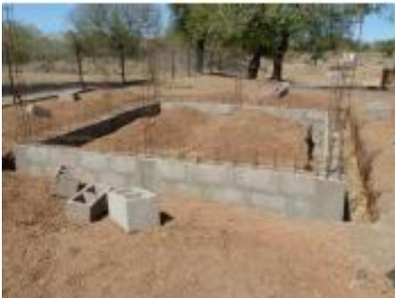
**Antecedentes:** En general, zapatas aisladas o corridas de hormigón armado. En una de las escuelas los pilares no tienen zapata, y los BTC's que rodean los pilares apoyan directamente en la arena compactada. Algunas escuelas tienen cimentación ciclópea.
