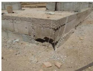
**ZOCALO** Problema en zócalo del edificio al quitar el encofrado de madera porque se la estaban comiendo las termitas, se levanta el hormigón, ya que todavía era pronto.
