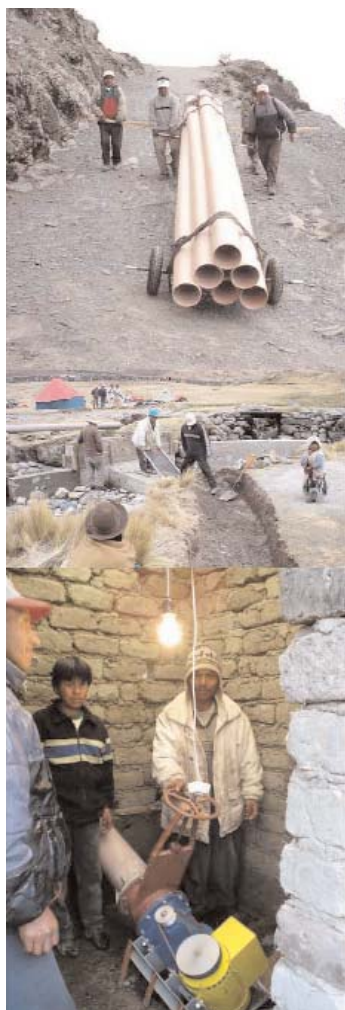
Figura 5.51. Proyecto MPQ/LP/01010a. Construcción de pico-centrales hidro- eléctricas de Samañapampa y Challapampa (Galería de fotos PNCC)
