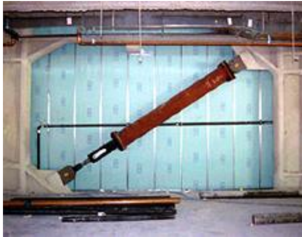
Figura 1.10 Ejemplo de disipadores viscosos
