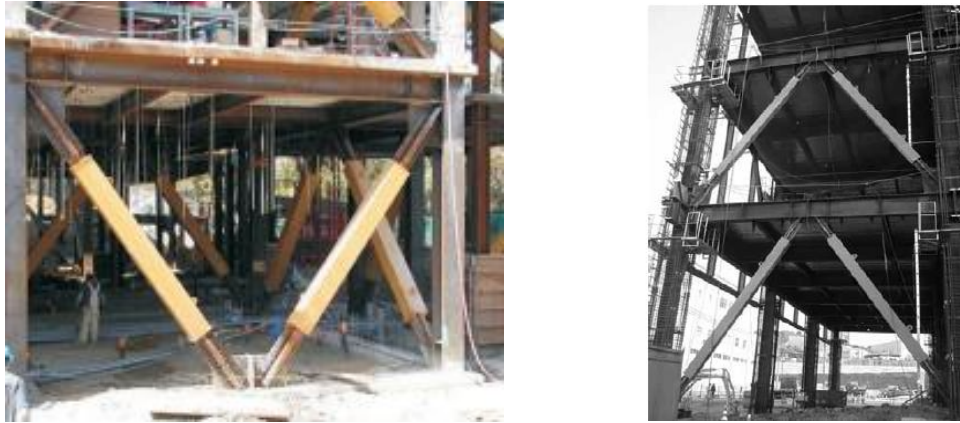
Figura 1.4 Ejemplo de disipadores metálicos (Contravientos)
