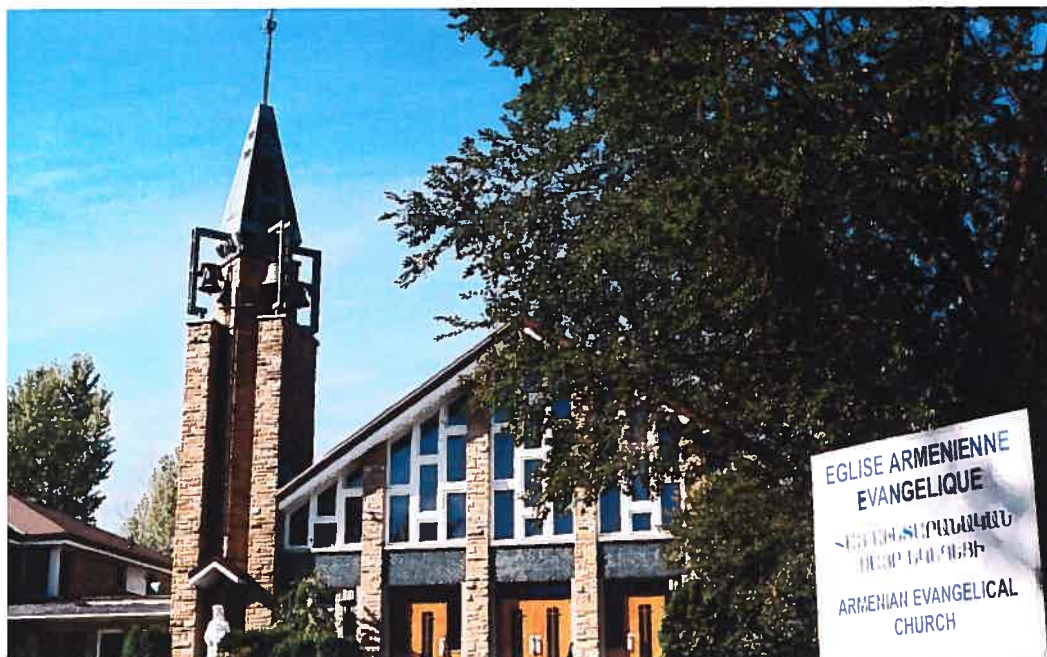
Photo 11: Église arménienne évangélique (Laval)
