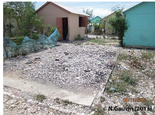
Espace d'une maison brûlée par vandalisme
