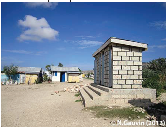
Accès aux latrines communautaires (sect.3)
