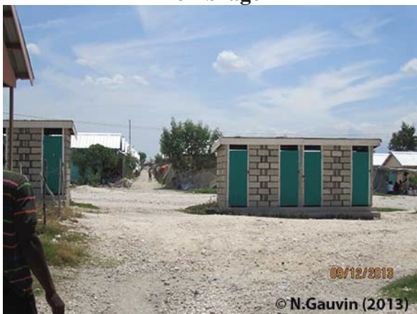
Accès aux latrines communautaires
