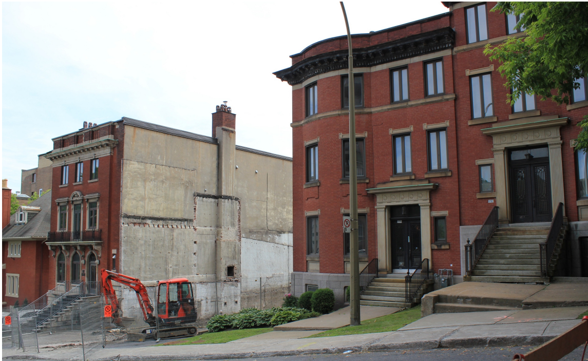
Figure 15. 3680-3702, avenue de la Montagne pendant les travaux, dans Ville-Marie. Photo : N. Nadeau, 2014
