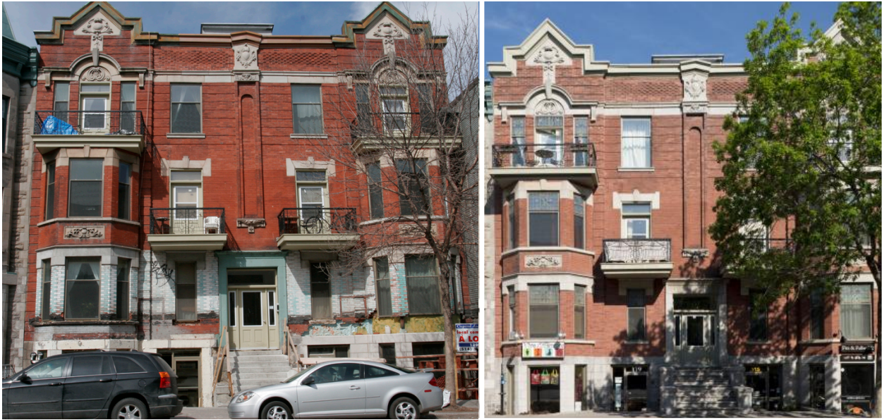
Figures 11 et 12. 115-117, avenue Mont-Royal dans Le Plateau. La photo de gauche présente l'édifice avant les travaux, celle de droite après les travaux. Photos Arrondissement Le Plateau, dates inconnues.
