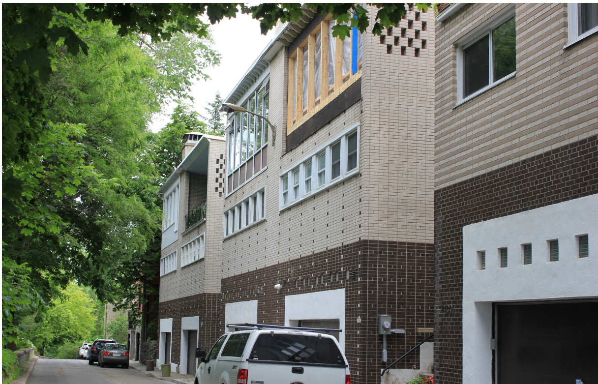
Figure 13. Groupe de bâtiments sur le chemin de Trafalgar dans Ville-Marie. La façade du 4110 est mitoyenne à celle en travaux. Photo N. Nadeau, 2014
