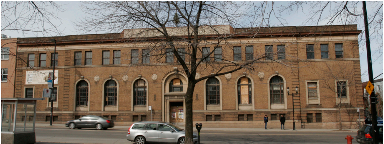
Figure 18. Édifice situé au 265, avenue Mont-Royal dans Le Plateau avant les travaux de transformation. Source : arrondissement Le Plateau, date inconnue.
