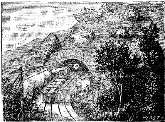
TUNNEL DE LA NERTHE, PRÈS DE MARSEILLE. — Un tunnel est un passage pratiqué sous terre ou à travers une montagne, dans lequel s'engagent les trains de chemin de fer. Le plus
