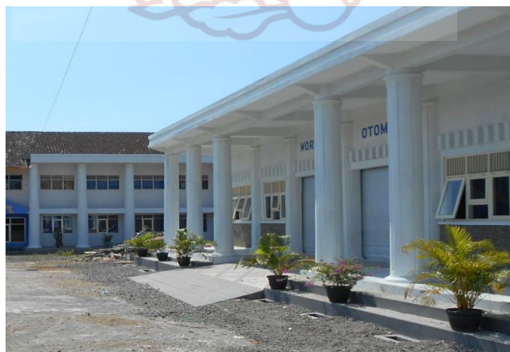
Gambar 5 Gedung SMK Muhammadiyah 2 Sayung-Demak (Foto : Nunuk Nur Shokiyah)
