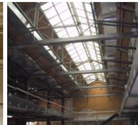
ursprünglicher Zustand der Hallenkonstruktion
