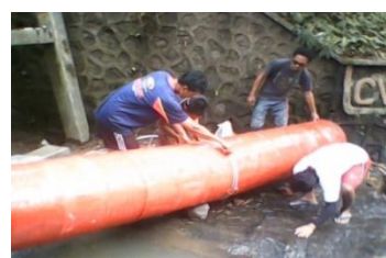
Gambar 4. Drum sebagai power house
