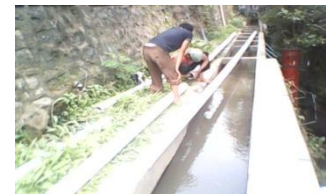
Gb 10. Penyambungan pipa di lokasi pembangkit
