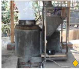
Co-firing Batubara-Biomassa Menggunakan Pembakar Siklon untuk IKM
