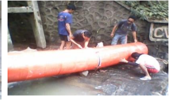
Gb 8. Menyambung drum dengan baut dilokasi pembangkit
