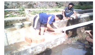
Gb 12. Pemasangan pipa pada saluran masuk
