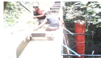
Gb 9. Pemasangan penyangga pipa saluran
