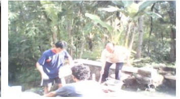
Gb 6. Pembangunan pintu saluran
