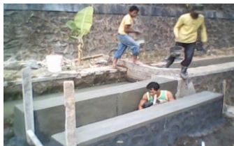
Gb 4. Pembangunan Pintu Saluran
