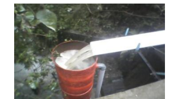
Gb 14. Pengujian sistem pembangkit dari saluran pipa
