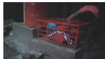
Gb 13. Pemasangan pengaman turbin dan generator
