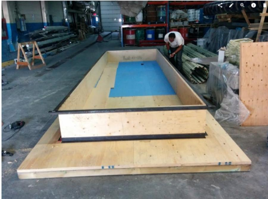
Figure 3-8 : Base et bords du coffrage montés
