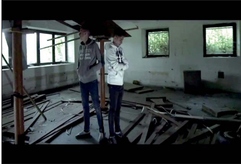
Abb. 63 M25: Rapper im Abrisshaus
