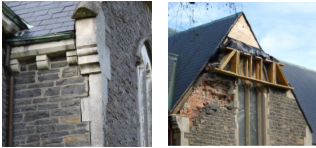
Figura 15. Immagini del danno associato ai meccanismi del transetto della Chiesa di St.Peter.
