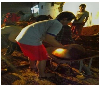
Gambar 2. Santri sedang ro'an pembangunan pondok
