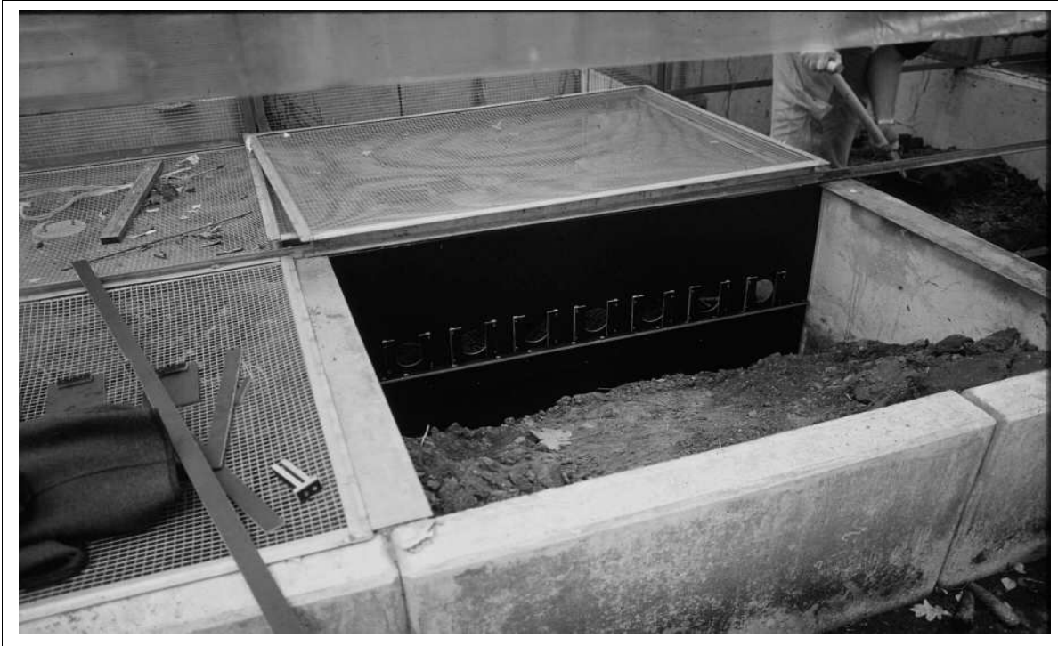
Abb. 1.17: Versuchsgehege, Trennwandeinbau: der Absatz zwischen oberer und unterer Trennwandhälfte entspricht dem späteren Bodenniveau. Im oberen Trennwandteil befinden sich durch Fallschieber verschließbare Durchschlupflöcher zwischen „Wohnteil“ und „Experimentierteil“ der Gehege.
