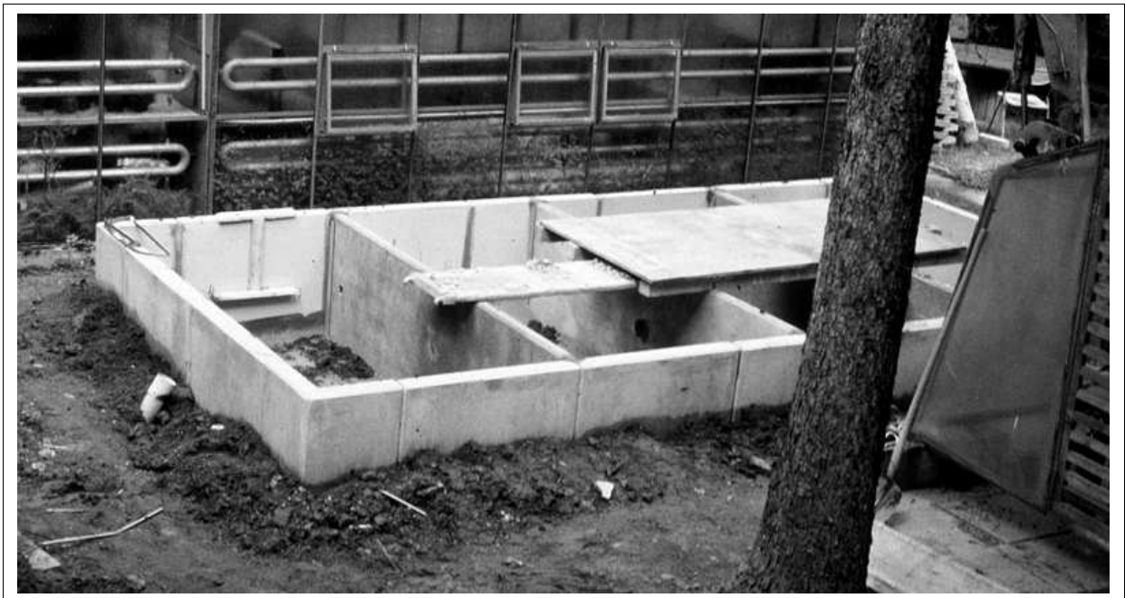
Abb. 1.16: Versuchsgehege, Grundstruktur aus Betonelementen, bis zur Füllhöhe im Boden versenkt
