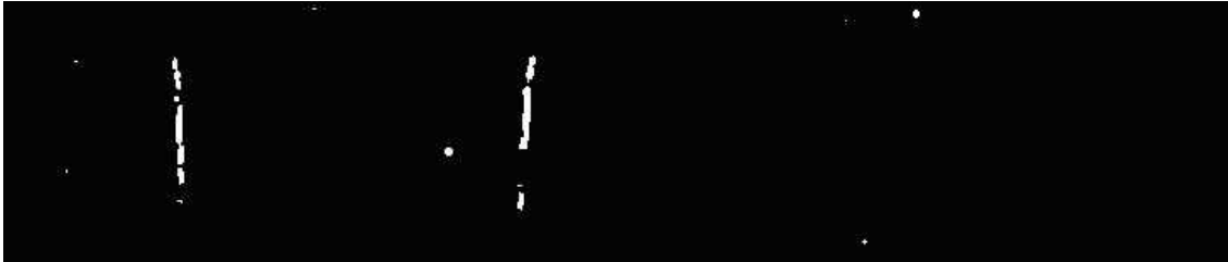
Figura 5.16 – Trinca Transversal Segmentada.
