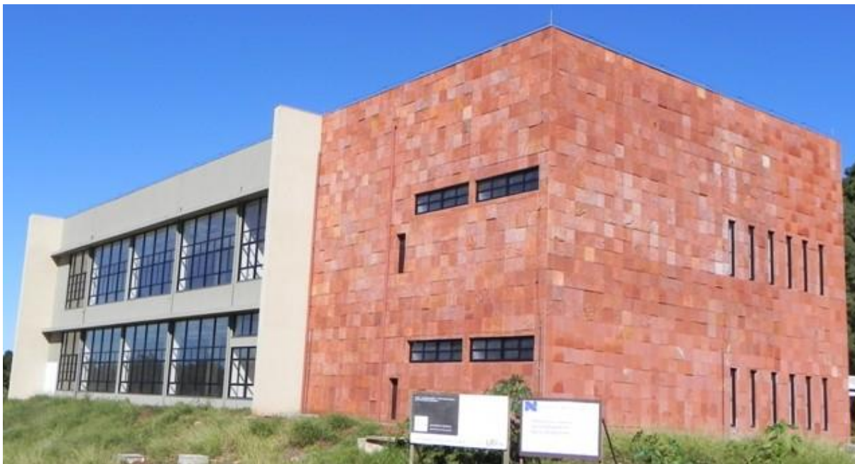
Figura 14 – Fachada – Biblioteca Ponta Grossa Fonte: UTFPR (2014)
