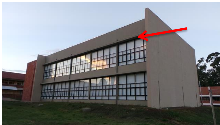
Figura 53 – Fotografia – Fachada 1 da biblioteca de Ponta Grossa Fonte: Autoria própria
