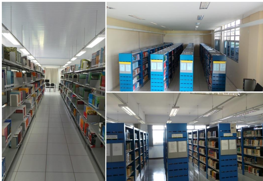
Figura 38 – Fotografia – distribuição das luminárias nas áreas de acervo Fonte: Autoria própria
