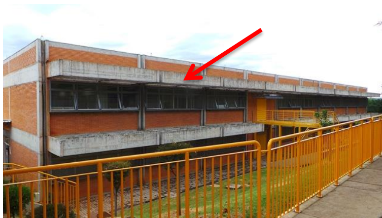
Figura 56 – Fotografia – Fachada 3 da biblioteca de Pato Branco Fonte: Autoria própria
