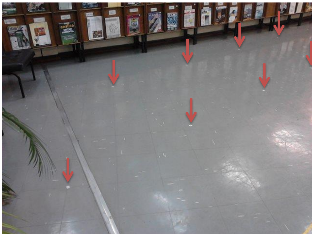
Figura 20 – Fotografia – marcação dos pontos de medição Fonte: Autoria própria
