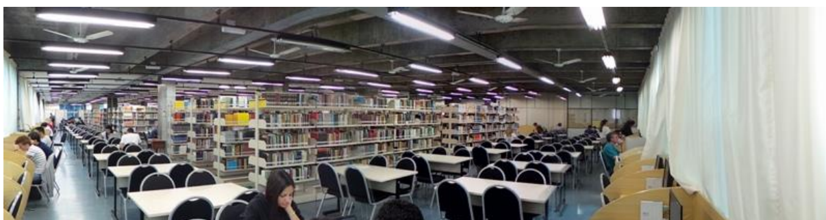
Figura 43 – Fotografia – Ofuscamento provocado por luminárias sem defletores – biblioteca de Curitiba - Centro Fonte: Autoria própria
