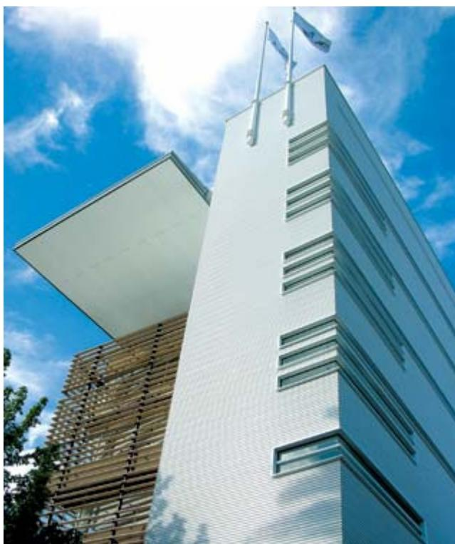
**FIGURA 2 – USO DE BRISES PARA PROTEÇÃO SOLAR DE ABERTURAS ENVIDRAÇADAS**
