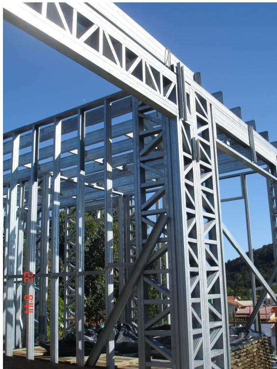
**FIGURA 11 – SISTEMA CONSTRUTIVO “STEEL FRAME”**
