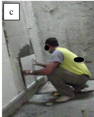
c Aplicar cerâmica em parede- “baixo”- Posição 2b
