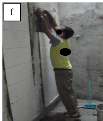
f Aplicar argamassa em parede – “cima” – Posição 4a
