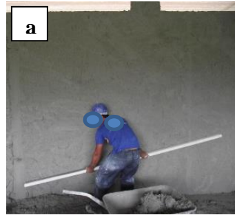
a Régua direcionada sentido: base-centro da parede
