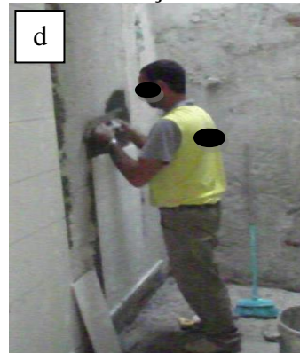
d Aplicar argamassa em parede - “meio”- Posição 3a
