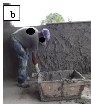
b Aplicar a argamassa na parte baixa da parede
