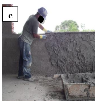
c Aplicar a argamassa no meio da parede
