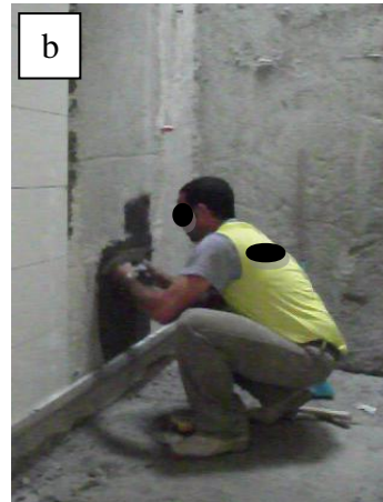
b Aplicar argamassa em parede – “em baixo” – Posição 2a
