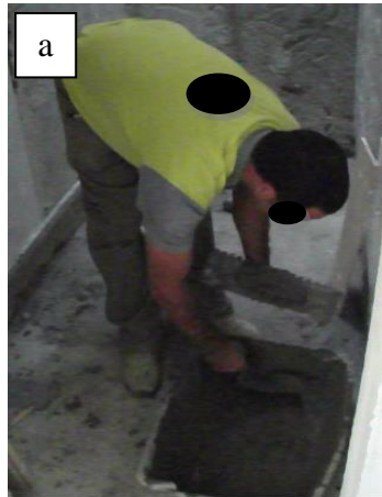
a Pegar argamassa em masseira – Posição 1
