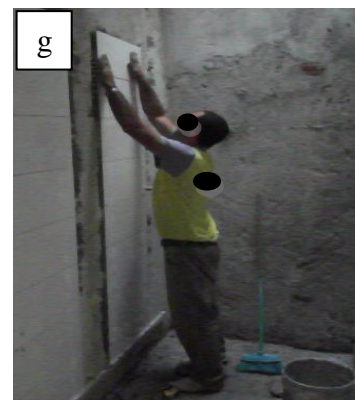
g Aplicar cerâmica em parede – “em cima” – Posição 4b
