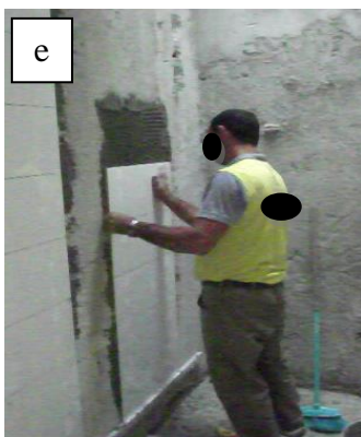
e Aplicar cerâmica em parede – “meio” – Posição 3b
