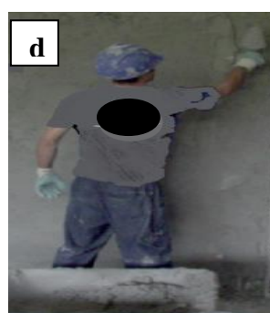
d Aplicar a argamassa na parte de cima da parede
