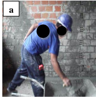
a Pegar a argamassa
