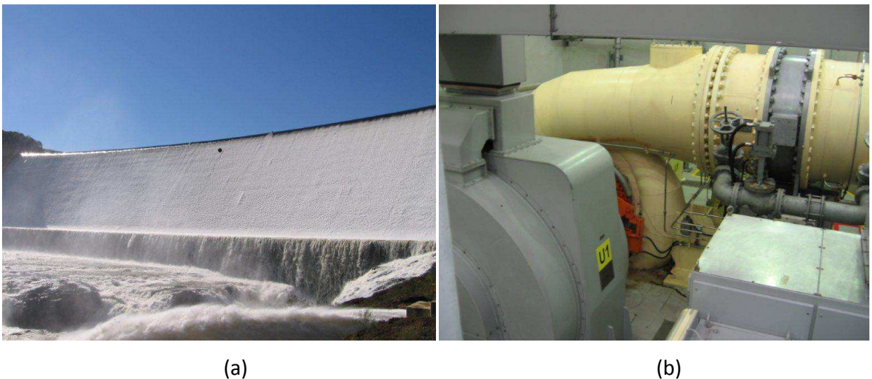
Figura 1. Fotografias da UHEDRJ em (a) Vertedouro e (b) Piso do Gerador.
