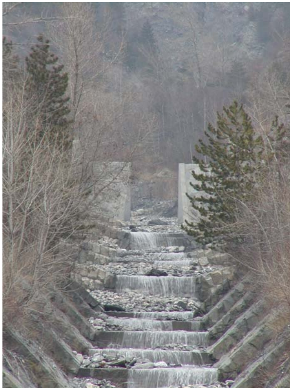
(D) River training on Ravin de Saint Julien, Saint-Julien-Mont-Denis, Vallée de la Maurienne (France) on 11 Feb. 2004 - Note the slit check dam in background
