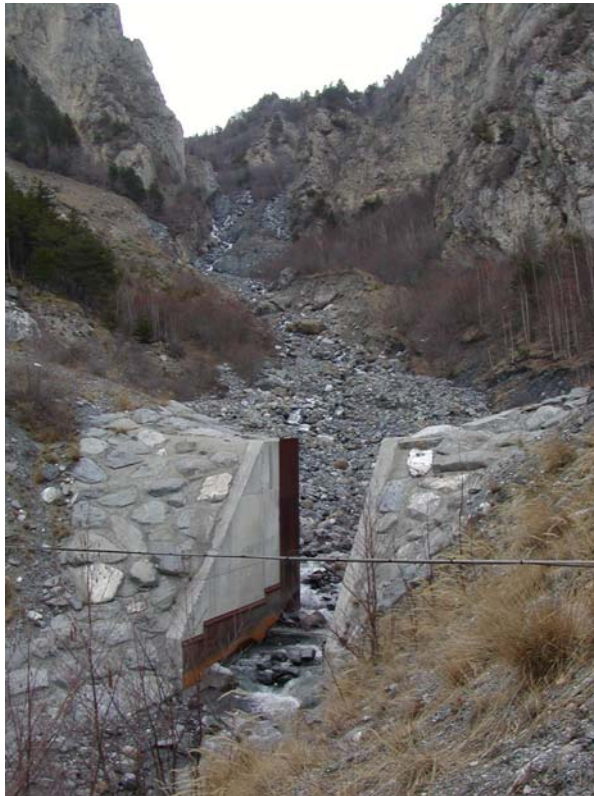
(D) River training on Ravin de Saint Julien, Saint-Julien-Mont-Denis, Vallée de la Maurienne (France) on 11 Feb. 2004 - Note the slit check dam in background
