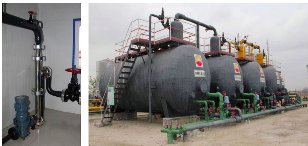
图 2 旋流管的工业应用(左 新型旋流分离器,右 原重力沉降分离器)
