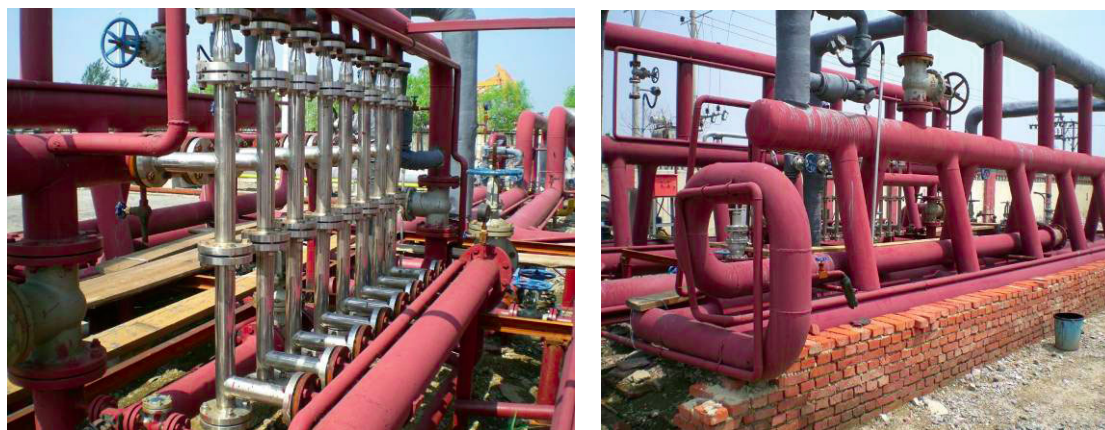
图 3 旋流管+T型管的管道式分离器的工业应用
