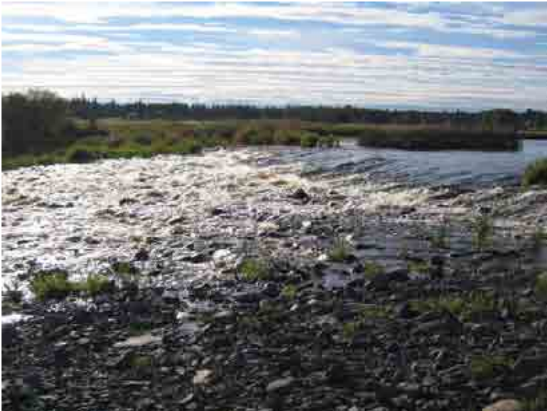
Kuva 48. Piipsjärven säännöstely hoidetaan luusuassa olevalla pohjapadolla, joka muodostaa miltei täydellisen nousuesteen kaloille.
