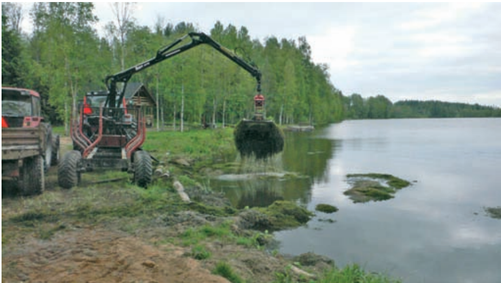
Kuva 21. Ruutinlammella kanadanvesiruton poisto järvestä onnistuu traktoreilla, sillä ranta on riittävän kantava. Kuva: Milla Laita
