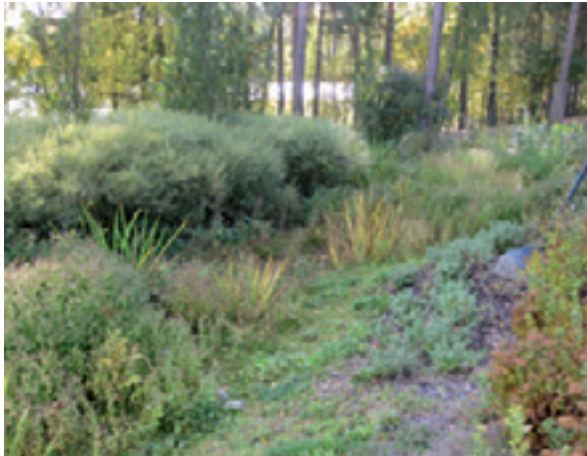
Geotekstiileillä suojattua puron luiskaa kaksi vuotta kunnostuksen jälkeen. TH
