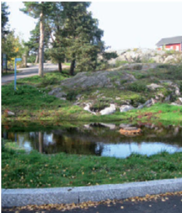
Hulevesien käsittelyä varten rakennettu vesiaihe Helsingin Korkeasaaresta. Imeytyspainanteessa on ylivuotokaivo. TH
