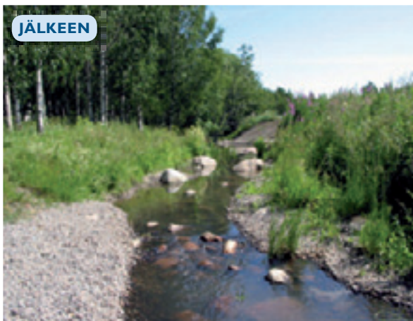
Longinojan Ala-Malmilla vuonna 2006 kunnostettua osuutta ennen ja jälkeen kunnostuksen. AS LH
