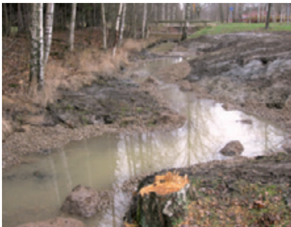
Longinojan uomaa monimuotoistettiin Fallkullan kunnostusalueella myös tulvasanteita rakentamalla. Samalla vähennetään tulvimisesta aiheutuvaa riskiä. TH
