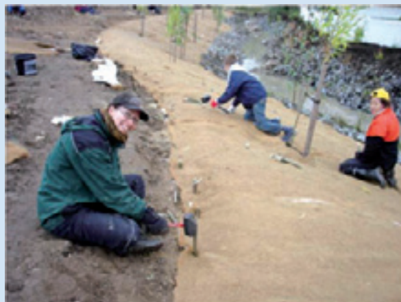
Geotekstiilit estävät uoman penkan syöpmistä heti kunnostustöiden jälkeen, jolloin kasvillisuus ei ole vielä ehtinyt kasvaa puron varteen. OS
