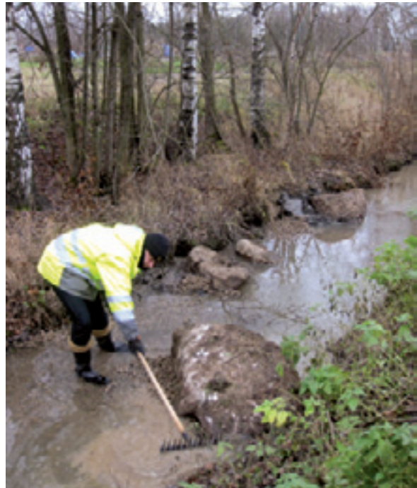
Kivien ja soran asettamista puroon Longinojan vuonna 2011 kunnostetulla alueella. TH
