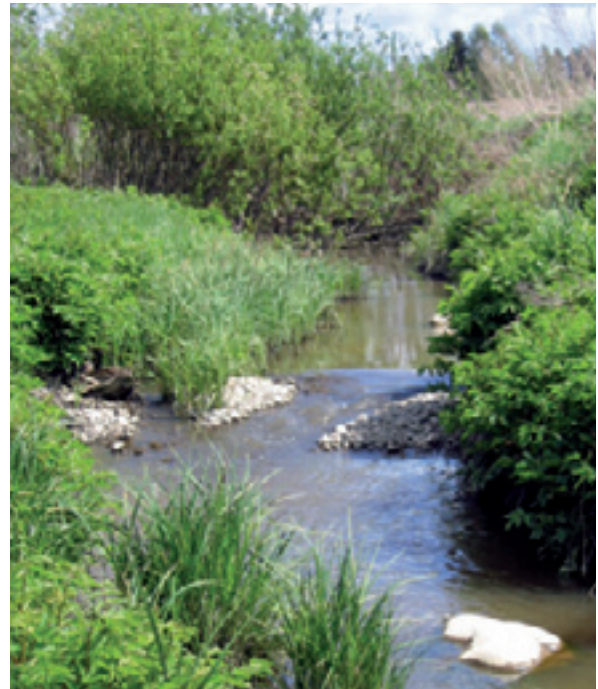
Puron virtausoloja voidaan helposti monipuolistaa sorasta tehtyjen kynnysten avulla. Kynnykset toimivat samalla kutusoraikkona. LH
