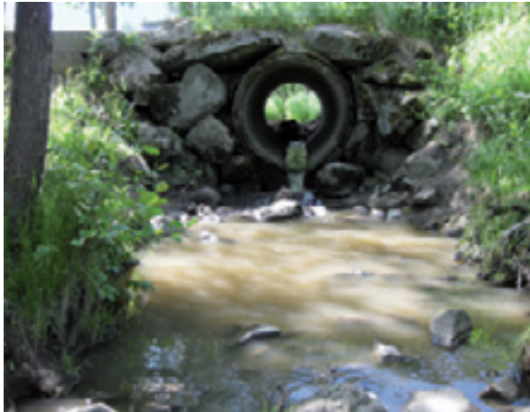
Syöpynyt tai liian korkealle asetettu siltarumpu voi olla nousueste kaloille. HA
