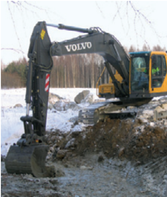
Uoman syvyyssvaihtelun lisääminen on helpointa tehdä kaivinkoneella. LH
