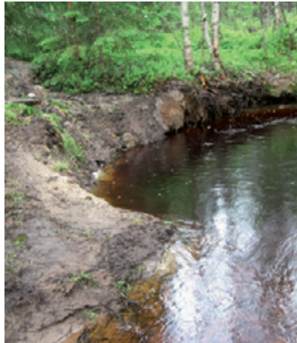
Uomassa kulkevaa kiintoainetta voidaan pidättää lietekuoppien ja laskeutusaltaiden avulla. Rakenteet vaativat kuitenkin säännöllistä tyhjentämistä toimiakseen kunnolla. AS
