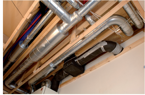
Kuva 21. Tulo- ja poistoilmaa varten tarvitaan pientalossakin IV-kanavia, joille pitää järjestää tila ja huoltomahdollisuus /Juha Sarkkinen/.
