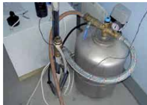
Kuva 15. Kalvopainesäiliö asennusvaiheessa.
