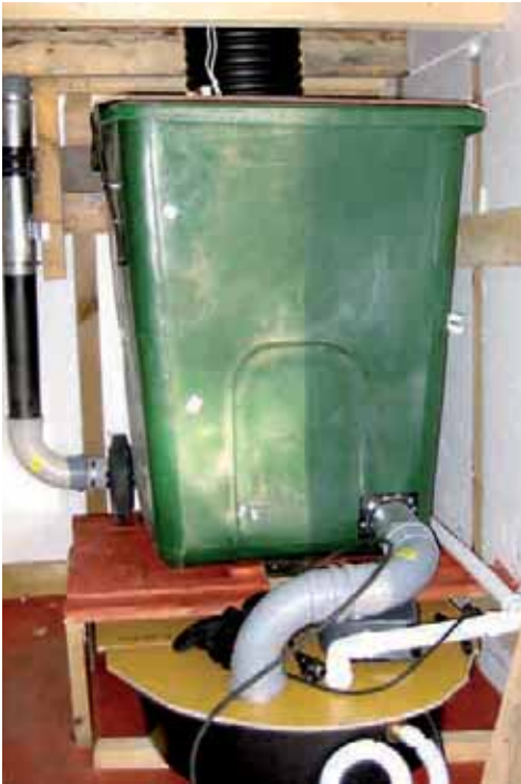
Kuva 54. Kuvan kompostikäymälään on kokeilumielessä lisätty suotonesteen haihduttamista varten erillinen laakea astia ja koneellinen alipainetuuletus.
