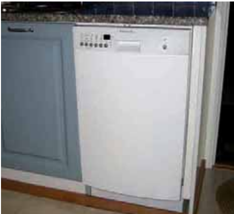
Kuva 22. Astianpesukoneen tyhjentäminen vedestä täydellisesti voi olla vaikeaa. Esimerkkejä valmistajien tyhjennysohjeista on liitteessä 4 c.
