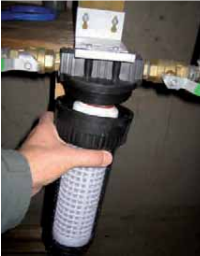
Kuva 16. Käytettäessä järvivettä mökillä pesuvetenä kannattaa vesijohtoon asentaa suodatin. Jos suodatin ei ole lämpimässä tilassa, se on tyhjennettävä samalla kuin vesijohdotkin ennen pakkaskautta.
