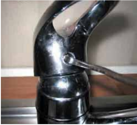
Kuva 67. Käyttövivun irrottaminen.
