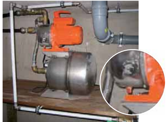
Kuva 14. Jos vesipumppu sijoitetaan tilaan, jossa lämpötila menee talvella nollan alapuolelle, se on tyhjennettävä ennen pakkaskautta. Pienessä kuvassa näkyy tämän pumppumallin tyhjennystulppa.
