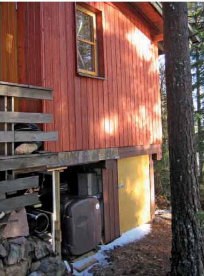
Kuva 40. Harmaa vesisuodattimenkin voi joskus sijoittaa mökin lattian alle. Tämän kohteen kompostikäymälä on esitetty kuvassa 54.
