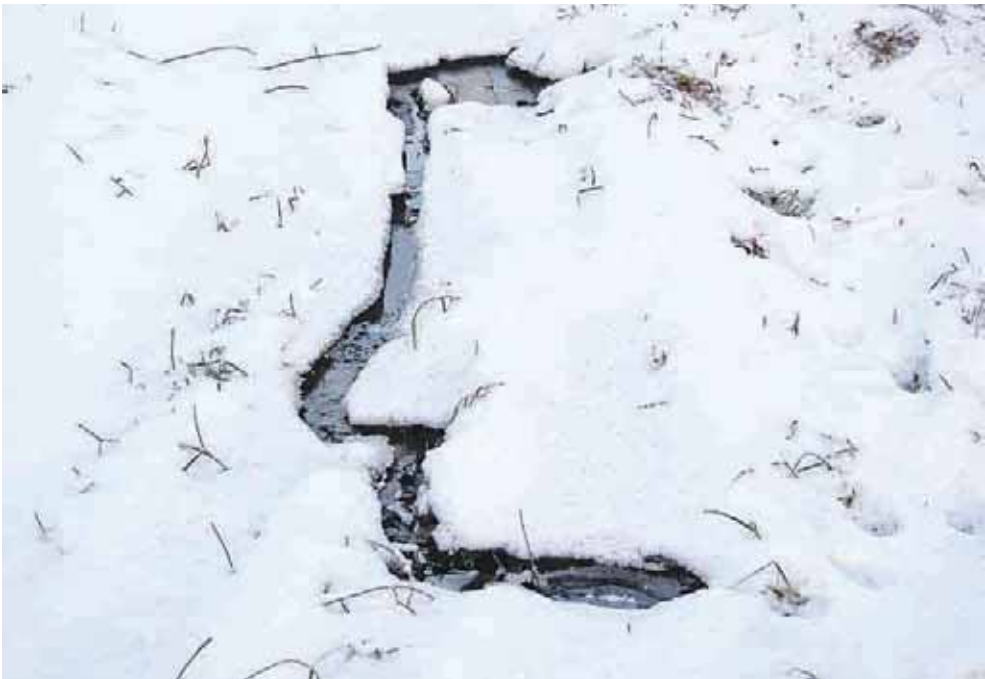
Kuva 32. Huonosti toimivassa imeytyksessä vesi nousee maanpinnalle ja jäätyy kovalla pakkasella.
