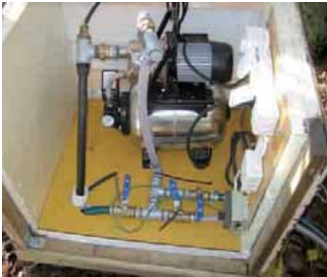
Kuva 4. Rakennuksen ulkopuolella järvi- ja vesipumppu voidaan lämmöneristää koteloinnilla ja tarvittaessa pitää lämpimänä sähkövastuksen avulla.
