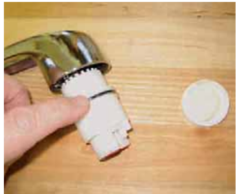
Kuva 72. Irrotuksen yhteydessä säättöosassa oleva kumitiiviste on syytä voidella erikoisvaseliinilla, jotta se kestäisi paremmin jokavuotisen irrotuksen ja kiinnityksen.
