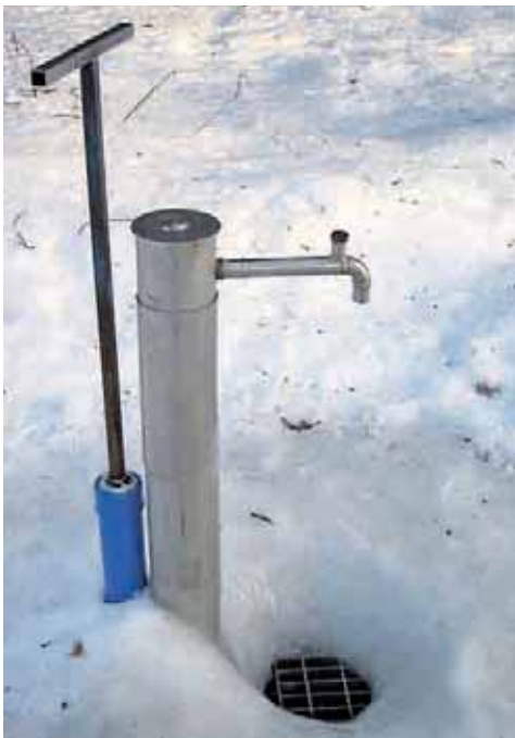
Kuva 38. Juoma- ja ruokaveden tuonti mökille muualta on yleistä silloin, kun omasta kaivosta ei saa tarpeeksi laadukasta vettä. Monet vesihuoltolaitokset ovat rakentaneet haja-asutusalueillekin vesiposteja. Talvikäytössä niiden toimivuus edellyttää sopivia rakenteita. Kuvan ympärivuotiseen käyttöön tarkoitettu vesiposti sijaitsee Kirkkonummella.
