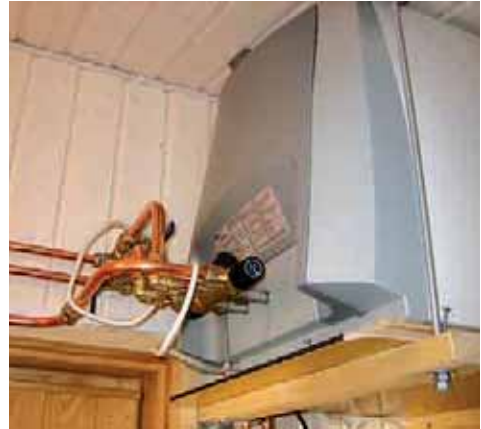
Kuva 18. Seinälle kiinnitetyn lämminvesivaraajan tyhjentäminen talveksi on helppoa, jos vesi voidaan valuttaa sopivaan kohtaan sijoitetulle tyhjennyshanalle. Tässä tapauksessa tyhjennys tehdään varoventtiilin tyhjennysputken kautta, tyhjennyshana on rajautunut kuvan ulkopuolelle. Lämminvesivaraaja on asennettu PAVE-hankkeen yhteydessä kuvassa 53 olevan mökin pesu- ja käymälätilan laajennusosaan.
