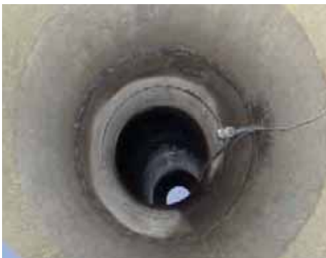
Kuva 6. Tyhjennysventtiilin asennuskohta pohjaventtiilin yläpuolella.
