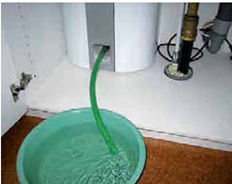
Kuva 17. Jos lämminvesivaraaja halutaan sijoittaa keittion alakaappiin, on valittava sellainen malli, jossa on tyhjennysyhde edessä alhaalla. Tyhjentäminen onnistuu valuttamalla vesi letkulla pesuvatiin tai lattiakaivoon. Laitteen valmistajan antamia ohjeita on noudatettava tyhjennyksessä ja uudelleen käyttöön ottamisessa.
