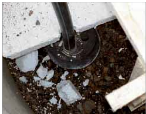
Kuva 7. Porakaivon huoltokaivo täyttyy lämmöneristää riittävästi.
