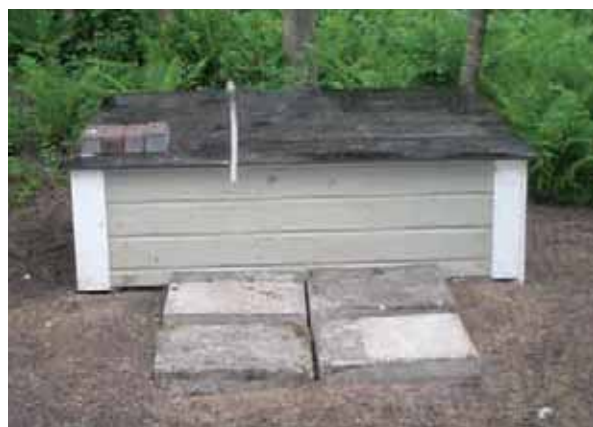
Kuvat 8–10. Vesimittarin kotelointi ja lämmöneristäminen rakennuksen ulkopuolella (Kuvat Heikki Pajula).
