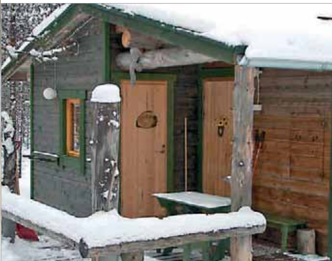
Kuva 51. Kompostoiva käymälä on tässä Loma-Metsä –hankkeen aikana Lapissa toteutetussa koekohteessa onnistuneesti rakennettu hyödyntäen avokuistia. Käynti käymälään on ulkoa, jolloin sen ilmanvaihto ja hoito on helposti järjestettävissä ongelmattomaksi. Kuitenkin matka mökin asuintiloista käymälään on lyhyt.
