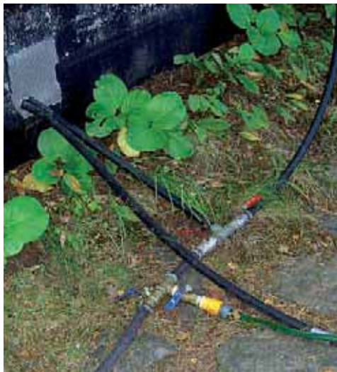
Kuva 20. Kaikki maanpinnalle sijoitetut kesävesijohdot on tyhjennettävä talveksi. Vaikka muoviset vesijohdotputket kestäisivät jäätyksen tyhjentämättöminä, liitoskappaleet ja venttiilit voivat rikkoutua.
