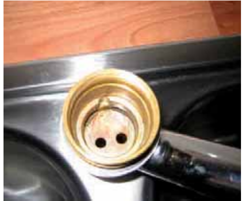
Kuva 71. Hanan runko jää irrotuksen jälkeen paikalleen.
