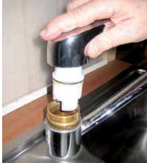
Kuva 70. Säättöosa vedetään pois käyttövivulla.
