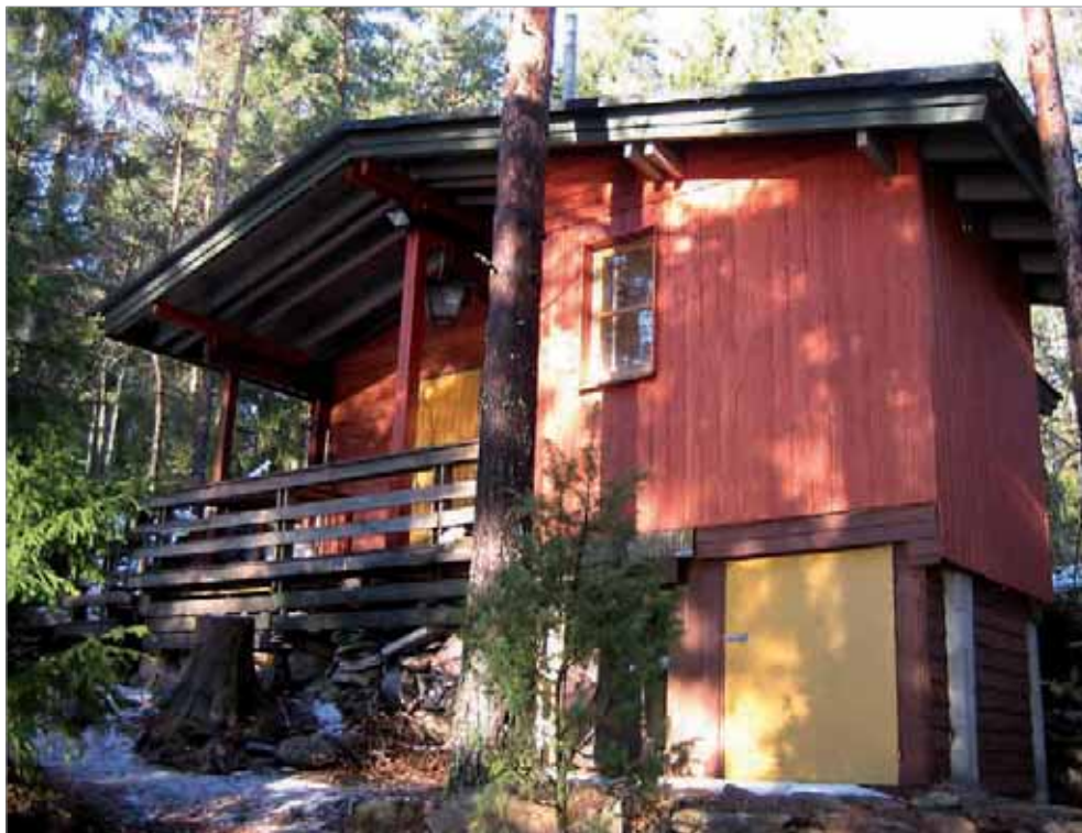
Kuva 53. Myös tässä mökissä Suomusjärvellä on hankekonsultin suunnittelema ja toteuttama käymälä ja pesutila onnistuttu rakentamaan laajennuksena avokuistin yhteyteen. Kuistin alle on tehty kokonaan lämpöeristetty tila kompostikäymälän säiliölle. Sen huoltamista ja tyhjennystä helpottaa iso luukku.
