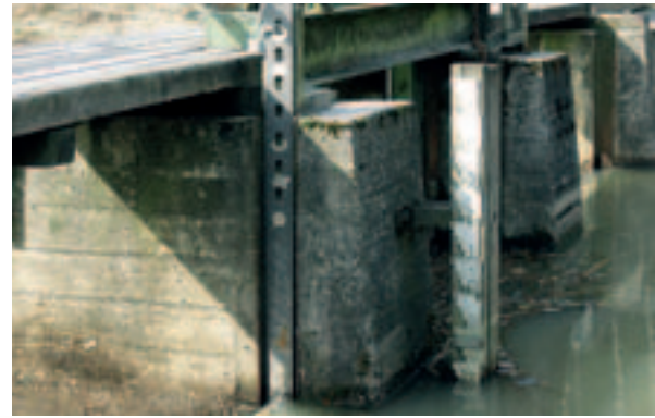
Vedenkorkeutta mitataan kiinteälle alustalle kiinnitetystä asteikolta. Kuvan mitta-asteikko on Tuusulanjärveltä.
