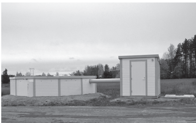
Kuva 2. Jätevesien panospuhdistamo. Vasemmalla maanalainen prosessiallas, oikealla konehuone. Isokaski Oy, Honkajoki. Kuva: Mikko Anttalainen
