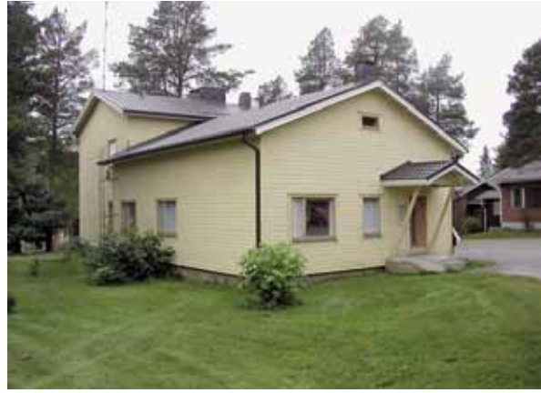
Kuva 31. Terveystalo vuonna 2003. Rakennukseen tehtiin mittava remontti vuosina 2008–2010. Tiina Elo 2003.
