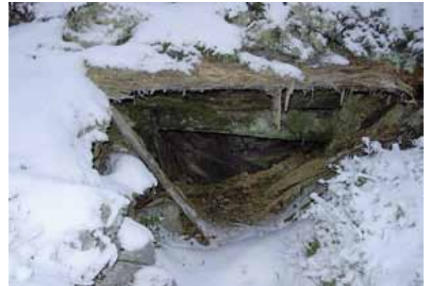
Kuva 171. Saksalaisten jatkosodan aikana rakentama asema Marjavaarassa Kuoskun lähellä. LKYT 2005.
