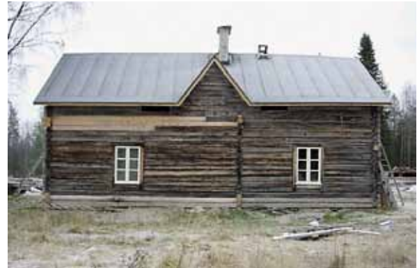
Kuva 118. Tarkkalan päärakennus takaa. LKYT 2005.
