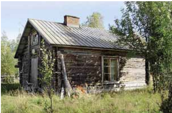
Kuva 114. Vanha pirtti on rakennettu vuosina 1931–1932. LKYT 2005.
