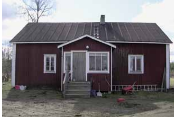
Kuva 110. Kyläsuvannon päärakennus on vuodelta 1934. LKYT 2005.
