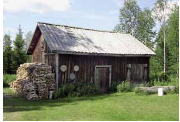
Kuva 83. Osa navetasta on purettu ja rakennus toimii nykyään liiteri- ja varastotiloina. LKYT 2005.
