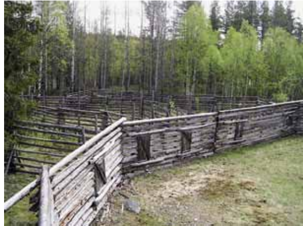
Kuva 35. Saarivaaran pääaidan jatkeena ovat pyöreä kurra (kirnu) ja sen ympärillä 12 konttoria. Näin Saarivaaran aidassa on kurra mukaan lukien suurten, parikilometristen siulojen jatkeena peräti viisi veräjin suljettavaa jaksoa. Kämpät ovat sijainneet hajallaan erotusaidan ympärillä. LKYT 2005.
