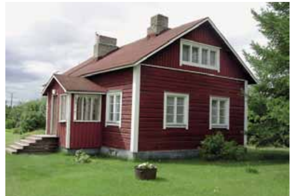
Kuva 76. Päärakennus on vuodelta 1947. LKYT 2005.
