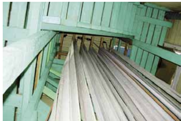
Kuva 49. Paloaseman letkutorni. LKYT 2005.
