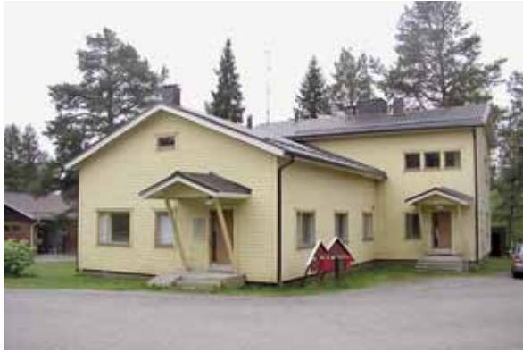
Kuva 46. Vanha terveystalo ennen remonttia. Tiina Elo 2003.
