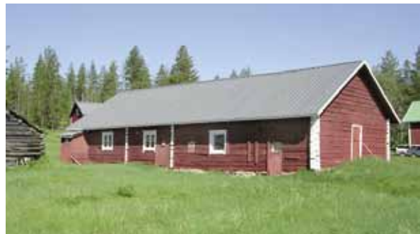
Kuva 122. Navettarakennus on vuodelta 1916. LKYT 2005.
