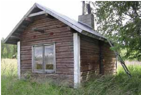
Kuva 99. Saunarakennus 1950-luvulta. LKYT 2005.
