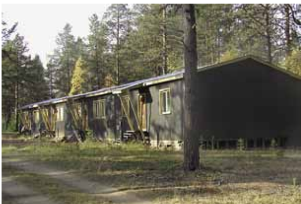
Kuva 24. Sokliin 1970-luvulla rakennettuja parakkimaisia rivitaloasuntoja. Tiina Elo 2004.
