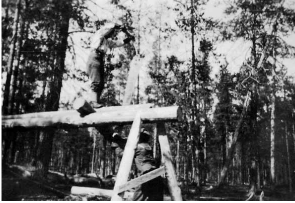
Kuva 186. Rakennuslautojen sahausta Saihon kämpän rakennustyömaalla. Matti Lönnströmin kuva-albumi.
