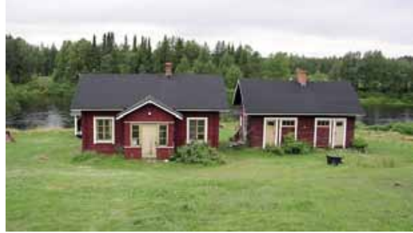
Kuva 91. Entinen Ylä-Kitisen uittopirtti ja saunarakennus, joka on ollut Alfhilda Torkkolan asuinmökki. LKYT 2005.
