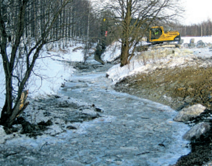
Kuva 20. Longinojaa kunnostettiin kaivamalla uoma vanhan, mutkittelleen linjauksen mukaiseksi. Kaivutyöt tehtiin talvella maan ollessa roudassa ja kantaessa hyvin koneita. Kuva Jukka Jormola.
