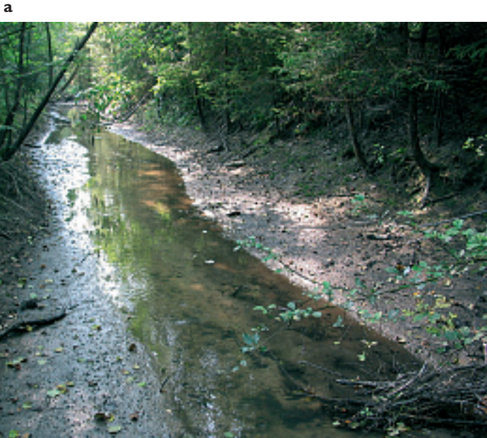
Kuva 13. Mutkittelun lisääminen lisää uoman monimuotoisuutta ja puroeliöstölle soveltuvien elinympäristöjen määrää. a) ja b) Nuuksion Myllypurolla puron perattu ja suoristettu uoma täytettiin ja puron alkuperäinen, mutkittleva perkausten yhteydessä täytetty uoma kaivettiin esiin vanhojen kartta- ja ilmakuvatietojen perusteella. Kuvat Lasse Järvenpää. c) ja d) Siuntion Kvarnbybäckenillä suoraksi perattua uomaa monipuolistettiin kaivamalla uoman linjausta hieman mutkittlevammaksi. Kuvat Harri Aulaskari ja Liisa Laitinen.
