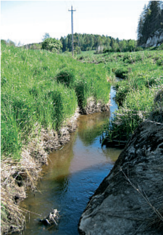
Kuva 6. Sopivissa maaperä- ja kaltevuusolosuhteissa peratut uomat alkavat palautua luonnostaan mutkitteleviksi. Jos kuivatussyvyys ja uoman vedenjohtokyky säilyvät elpymiskehityksestä huolimatta ennallaan, ei kunnossapitoperkauksia tarvita. Kuva Liisa Laitinen.
