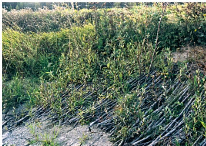
Kuva 15. Luonnonmukaisia eroosiosuojauksia voidaan rakentaa edullisesti pajusta. Rakenteet suojaavat ja sitovat syöpyvää luiskaa. Kuva Auri Sarvilinna.
