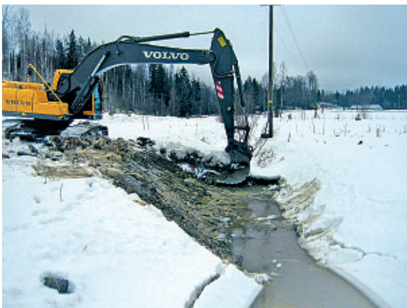
Kuva 8. Tulvatasanteen kaivua PURO-hankkeen tutkimuskohteella Siuntion Kvarnbybäckenillä. Työ on järkevä toteuttaa talvella: jäätynyt maa kantaa hyvin raskaat koneet ja samennushaitta jää vähäiseksi virtaaman ollessa pieni. Kuva Jukka Jormola.
