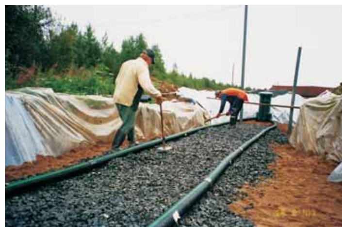
Kuva 27. Maasuodattamolla saavutettuja puhdistustuloksia ja kuva suodattamon tekovaiheesta. Kuva: Tanja Peltola, 2003.
