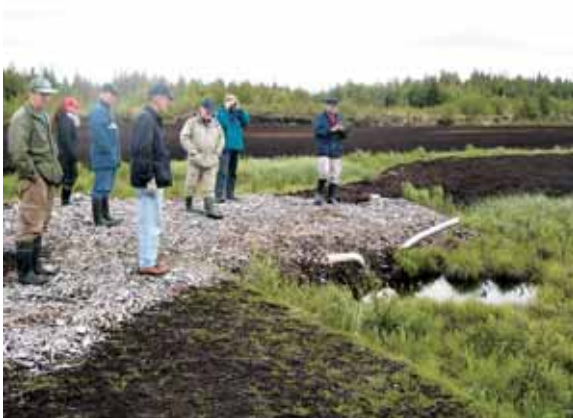
Kuvat 8 ja 9. Viidansuon hakepato ja massansiirtoallas. Kuvat: Pentti Åman, 2003.
