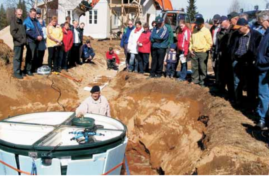
Kuva 24. Jäteveden pienpuhdistamon asennusnäytös Yli-Iin Leuanniemessä 2005. Kuva: Tanja Peltola, 2005.
