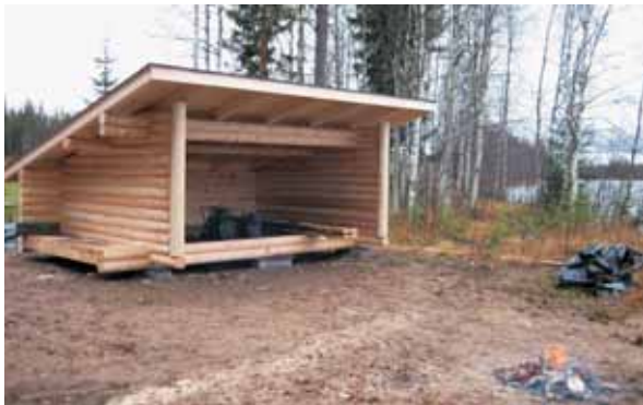
Kuva 37. Juhmun suvannon laavu vielä rakennusvaiheessa. Kuva: Tanja Peltola, 2006.
