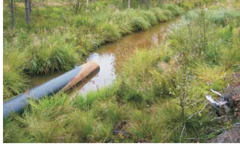
Kuvat 20 ja 21. Pumpausallas ja purkuputken suu, taustalla pintavalutuskenttää. Kuvat Sakari Jaara, 2004.
