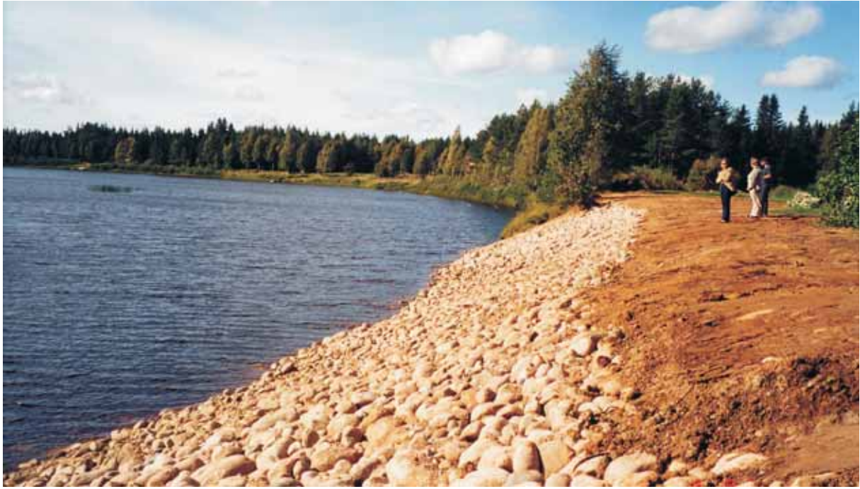
Kuva 38. Korjattu rantasortumakohde. Kuva: Tanja Peltola, 2002.
