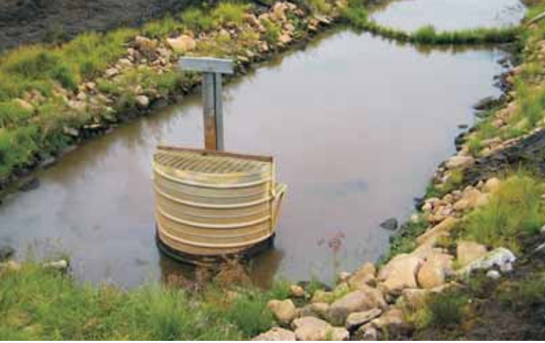
Kuvat 20 ja 21. Pumpausallas ja purkuputken suu, taustalla pintavalutuskenttää. Kuvat Sakari Jaara, 2004.
