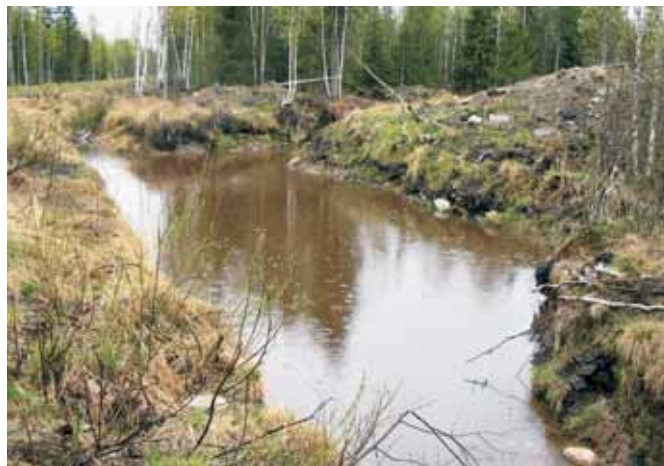
Kuvat 3 ja 4. Yli-lin Huiskanaroon toteutettu pintavalutuskenttä ja Kynkäänjojan varteen toteutettu laskeutusallas. Kuvat: Tanja Peltola, 2004.
