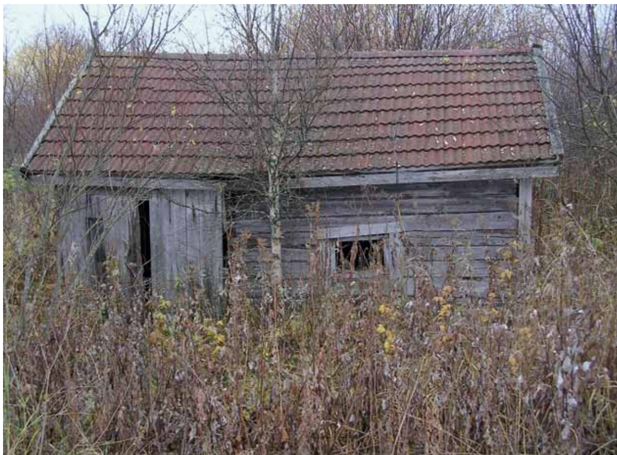
Kuva 251. Ilman käyttöä vaille jääneiden rakennusten ympäristö kasvaa nopeasti umpeen. LKYT 2006.
