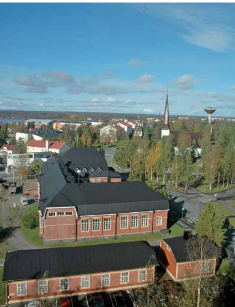
Kuva 220. Porthanin koulu sijaitsee kaupunkikuvallisesti tärkeällä paikalla. Minna Heljala 2012.
