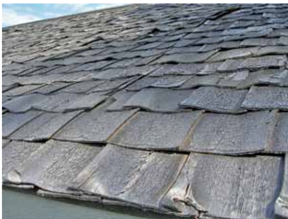
Kuva 197. Kala-aitan kattoa. LKYT 2007.
