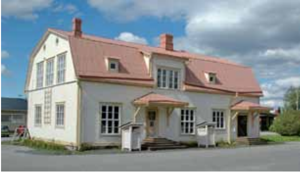
Kuva 171. Arpelan kauppaosuuskunnantalo. Minna Heljala 2012.
