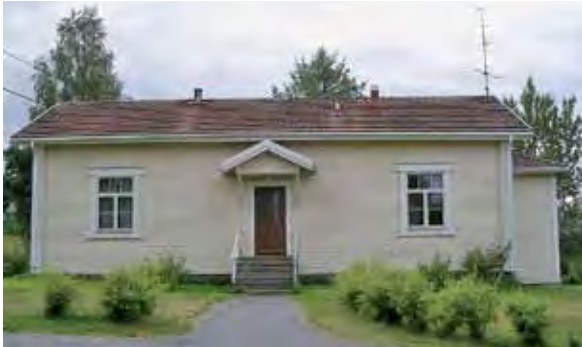
Kuva 97. Alatornion meijerin pihapiirin asuinrakennus. LKYT 2006.
