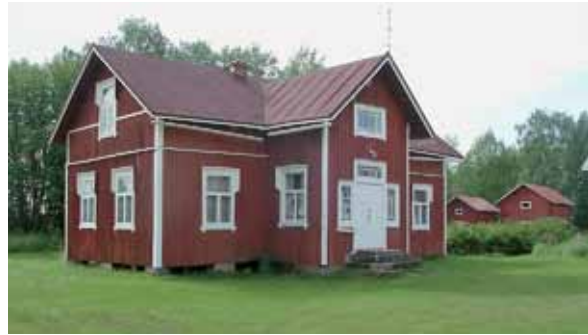
Kuva 155. Harjun päärakennus. LKYT 2007.
