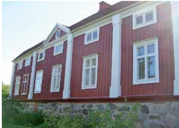
Kuva 132. Päärakennuksen takajulkisivu. LKYT 2006.
