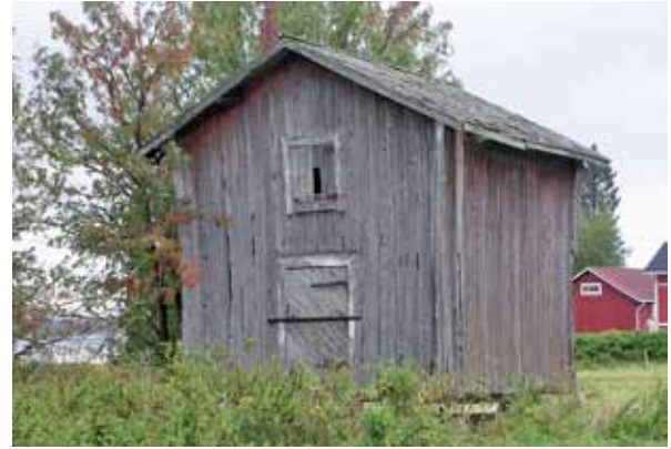
Kuva 192. Palon kaksikerroksinen ylöspäin levenevä aitta. LKYT 2007.
