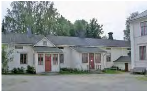
Kuva 55. Vanhempi asuinrakennus pihan puolelta. LKYT 2006.
