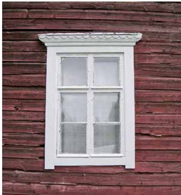
Kuva 194. Päärakennuksen ikkunoissa on koristellut otsalaudat. LKYT 2006.
