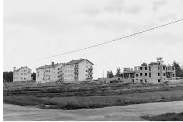
Kuva 30. Seminaarinkadun niin sanotut aravatalot rakennusvaiheessa. R. Kainulainen 1953. TLMM.
