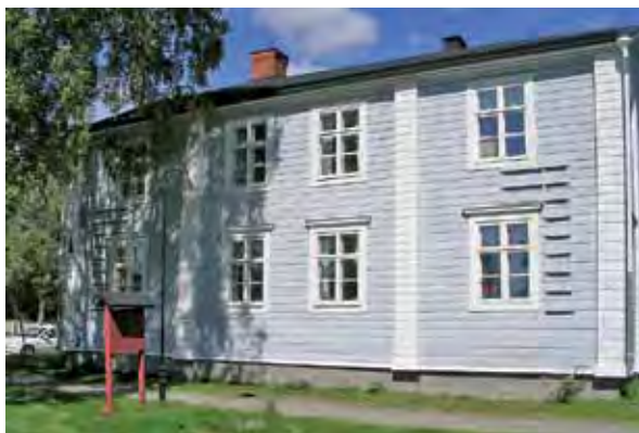
Kuva 62. Nyman Rantakadun puoleinen julkisivu. LKYT 2006.
