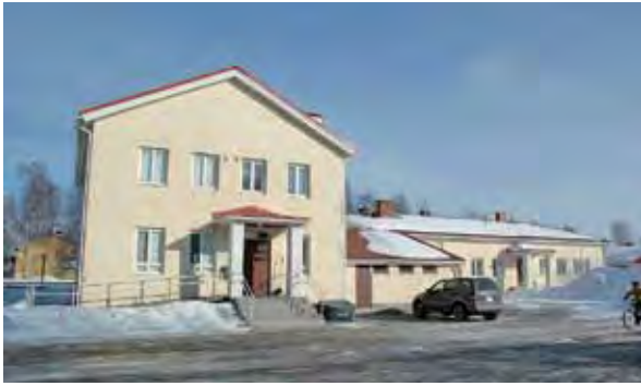
Kuva 93. Kivirannan terveystalo on tyypillinen esimerkki jälleenrakennusajalta. Minna Heljala 2012.
