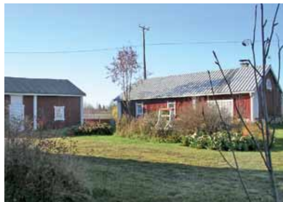
Kuva 130. Alavallon pihapiirin talusrakennuksia. LKYT 2007.
