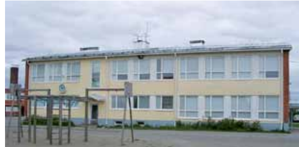
Kuva 233. Vuonna 1959 rakennettu koulurakennus. LKYT 2006.
