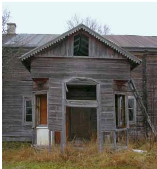
Kuva 107. Päärakennuksen etupuolella on kaksi kuistia, joista kuvassa mutterimallinen kuisti. LKYT 2004.
