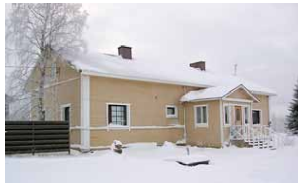
Kuva 88. Särkelänharjun uusi päärakennus. LKYT 2004.
