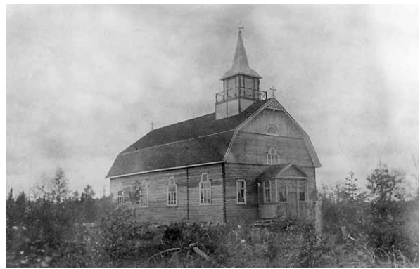
Kuva 16. Kirkko valmiina vuonna 1927. Kuvaaja tuntematon. Posion kotiseutuseuran kokoelma.
