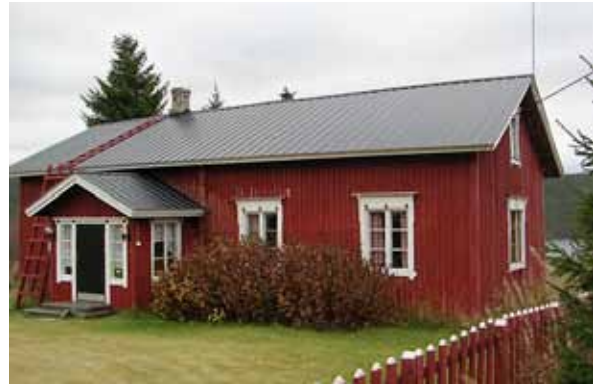
Kuva 71. Rajatalon päärakennus. LKYT 2005.
