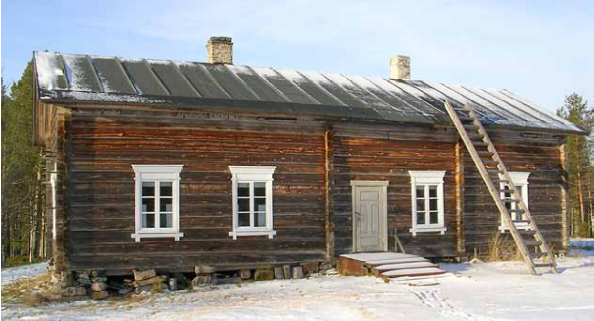
Kuva 86. Naumanniemen päärakennus. LKYT 2004.
