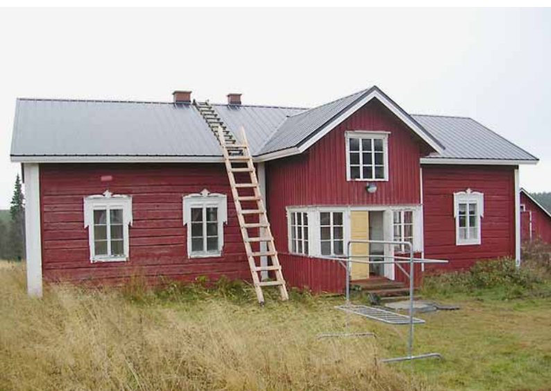
Kuva 113. Kelan päärakennus. LKYT 2004.
