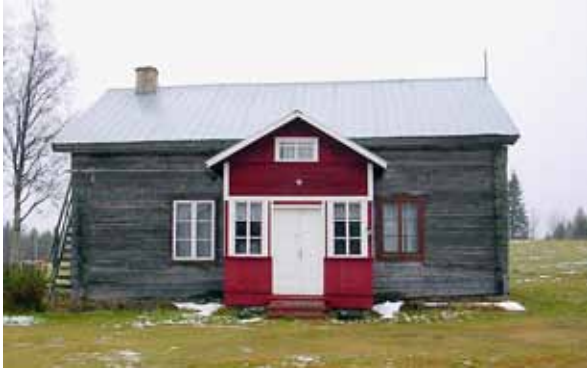
Kuva 105. Väinämön päärakennus. LKYT 2004.
