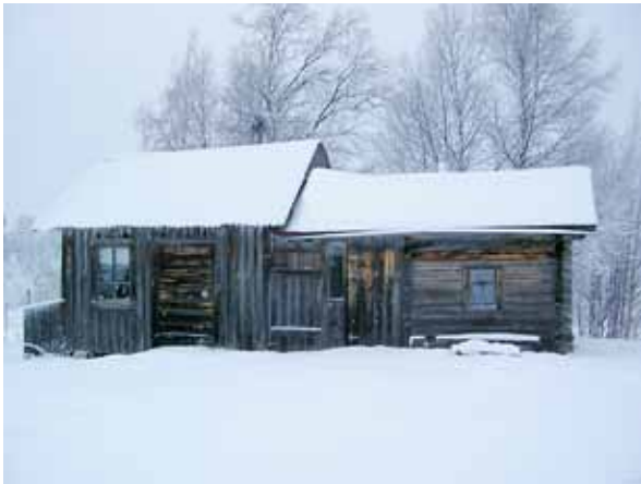
Kuva 36. Lato/navetta/maito huone -rakennus. LKYT 2004.
