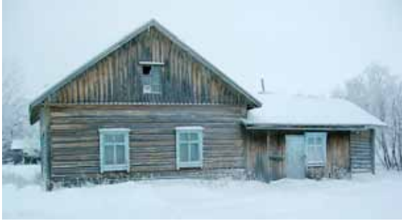
Kuva 99. Kaarelan päärakennus. LKYT 2004.
