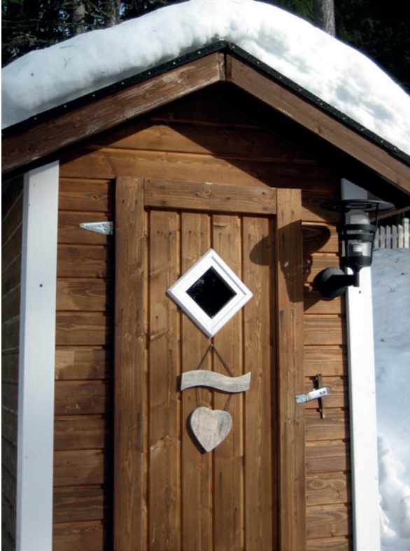
Kuva 43. Kuivakäymälät on hyvä pitää käyttökuntoisina esimerkiksi sähkökatkojen varalta.
