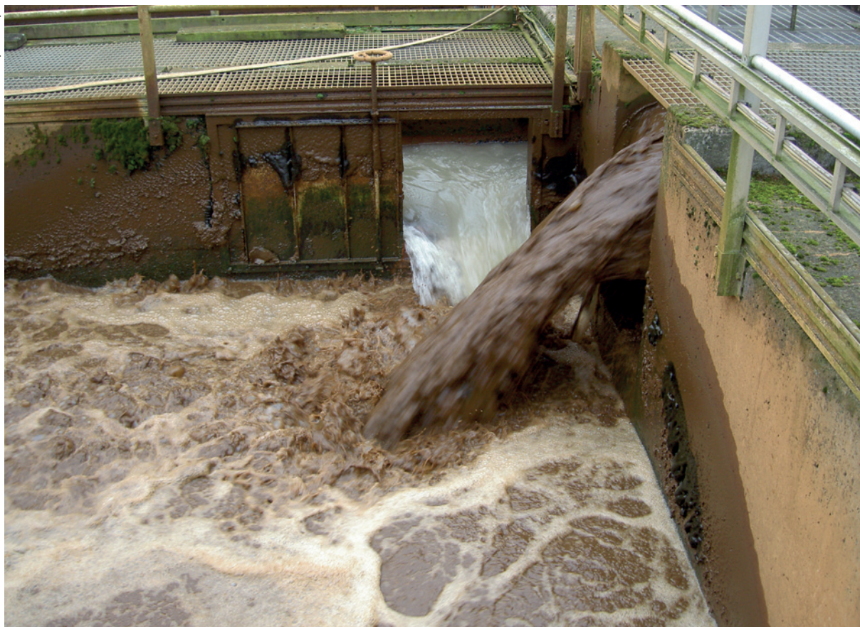
Kuva 38. Rankkasateet saattavat kuormittaa jätevedenpuhdistusprosessia huomattavasti, jos kapasiteetti ei ole riittävä. Tällöin osa puhdistettavasta vedestä voidaan joutua juoksuttamaan ohi varsinaisen puhdistusprosessin.
